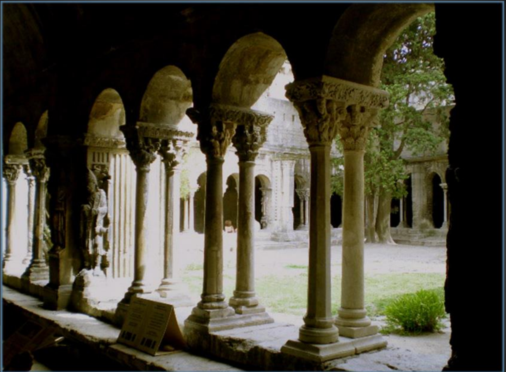
Le CLOITRE Détails des colonnades
