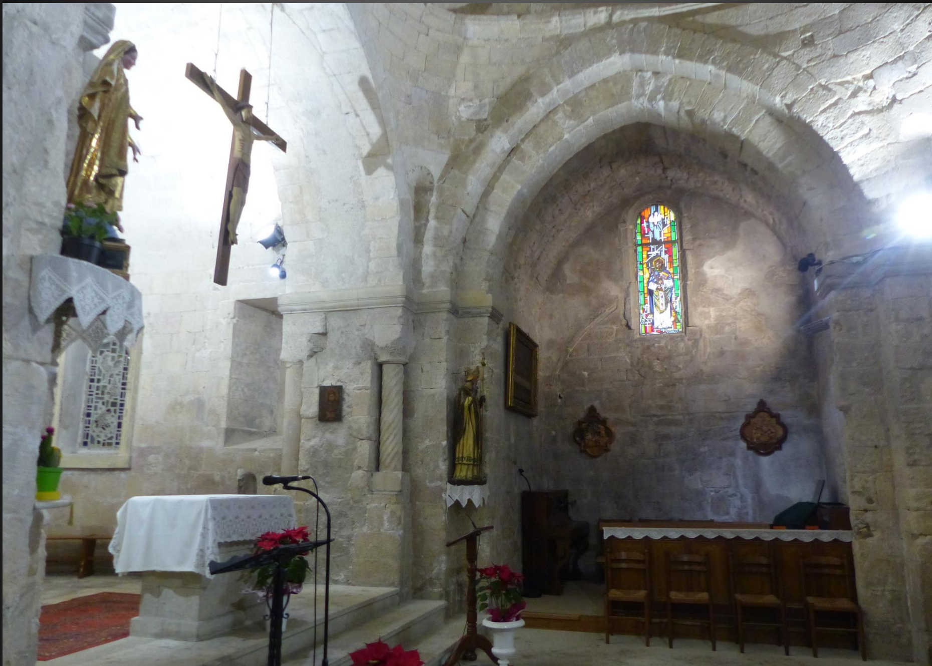
Eglise Saint-Césaire _ Un avant-chœur, à plan rectangulaire, précède le chevet. Ces avant-chœurs placés entre la nef et le chœur semi-circulaire ont probablement été créés pour accueillir dans des stalles des collèges de prêtres ou de chanoines. L'Arc triomphal ogival est supporté par des colonnes dont l'une est torsadée.
