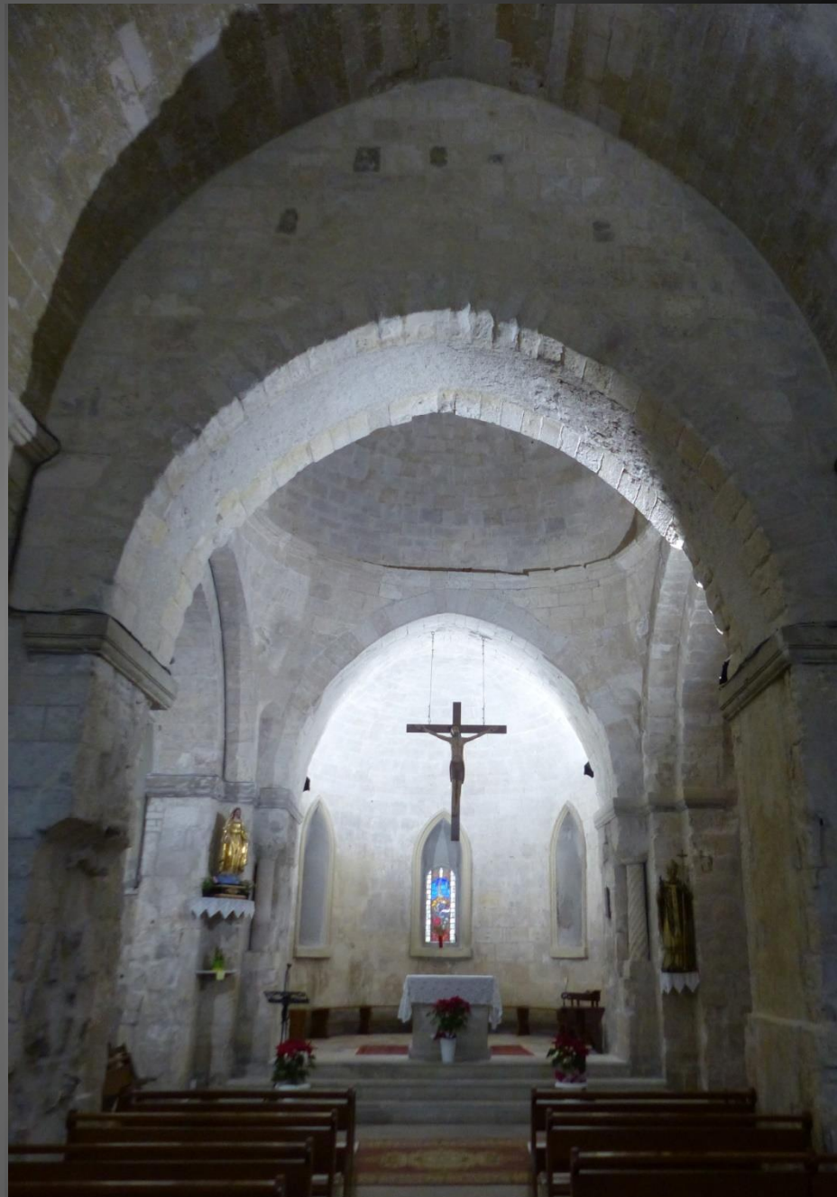
L'abside du XIe s., construite en petit appareil - pierre de Calissanne - est faiblement éclairée par une étroite fenêtré axiale, caractéristique d'un chevet ancien, probablement antérieur à l'an 1000.
