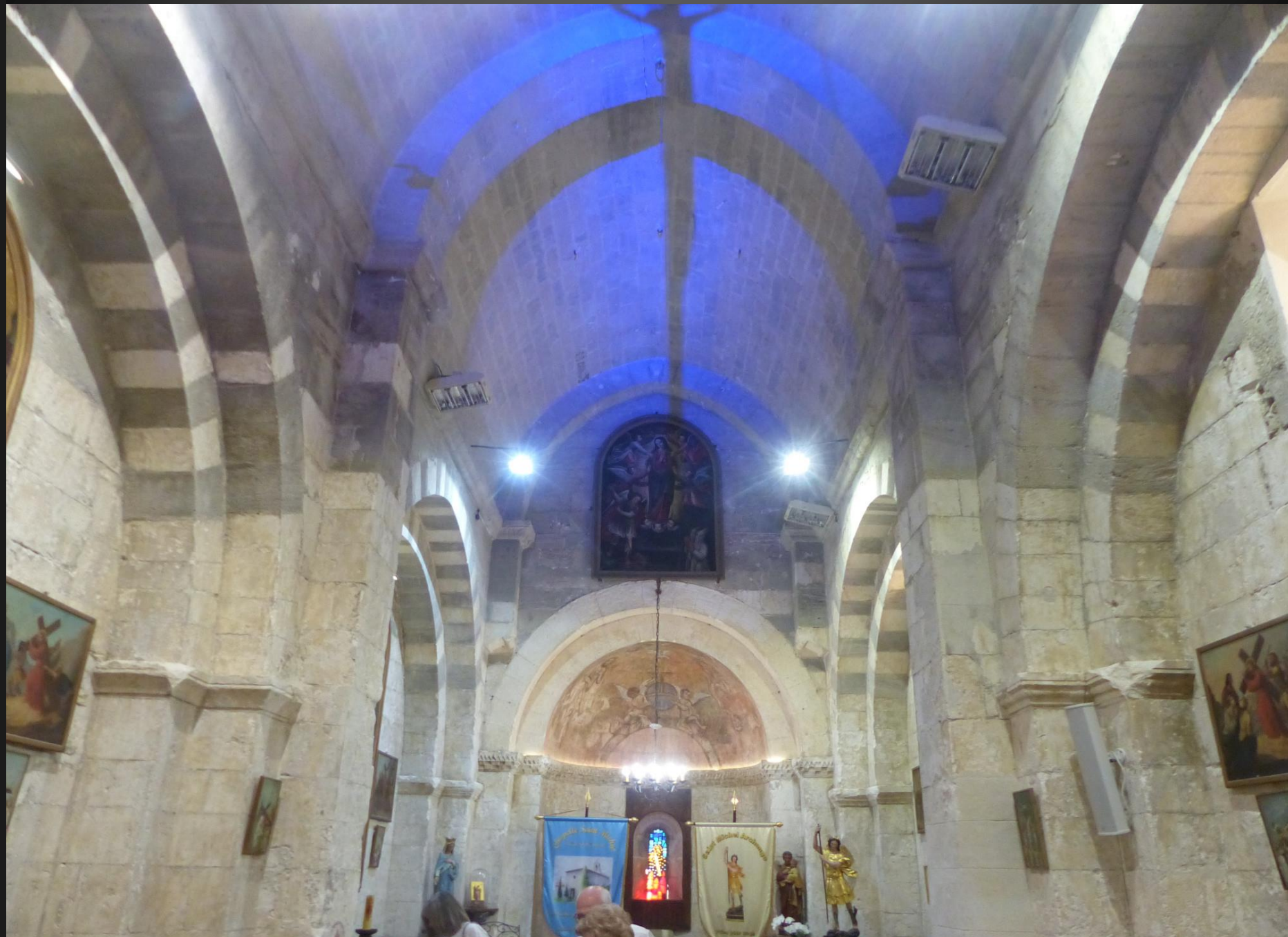
CABANNES _ La partie romane date du XIe siècle, avec une belle voûte en berceau brisé, le tout en pierres blanches d'Orgon.
