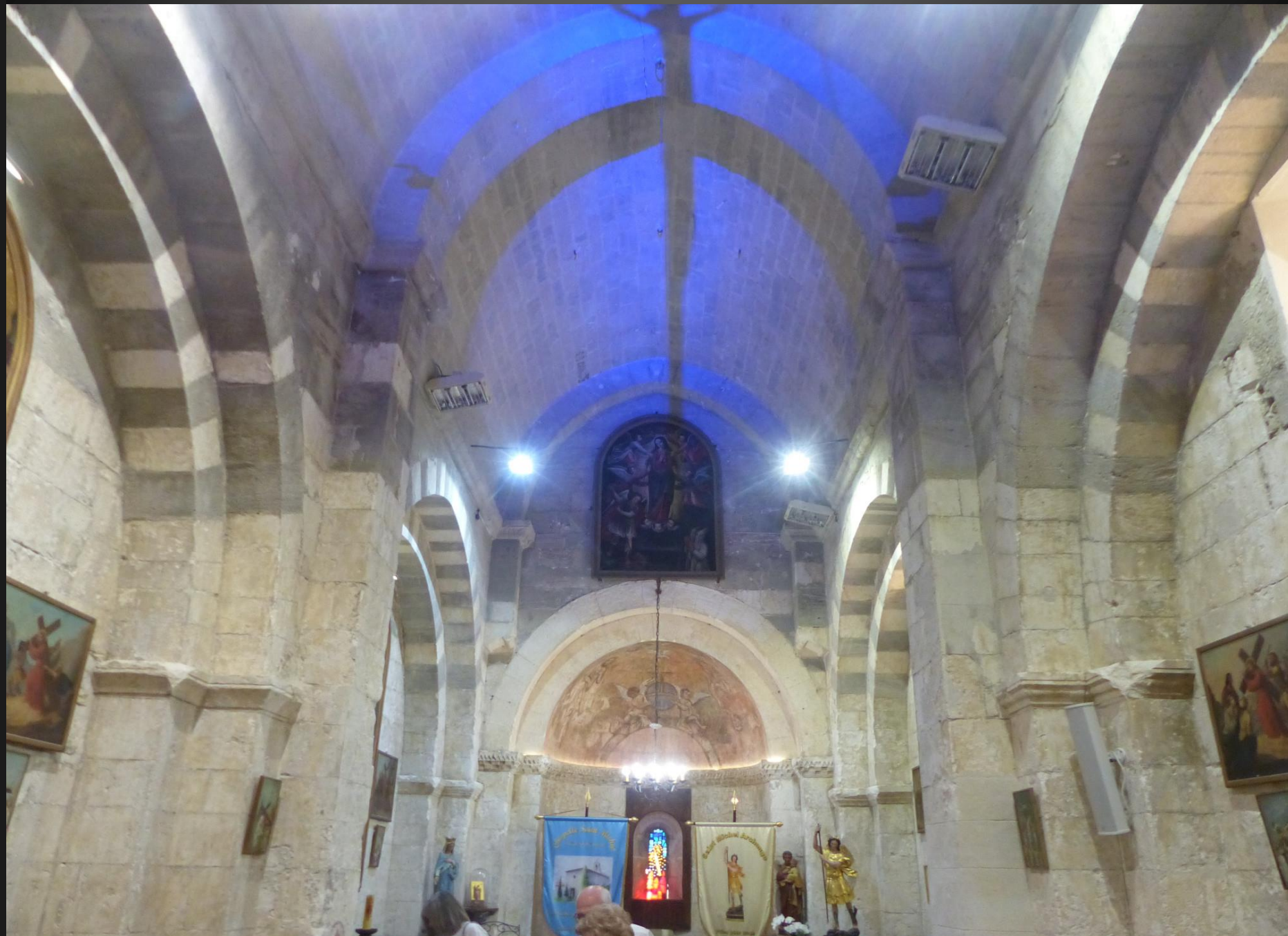
CABANNES _ La partie romane date du XIe siècle, avec une belle voûte en berceau brisé, le tout en pierres blanches d'Orgon.
