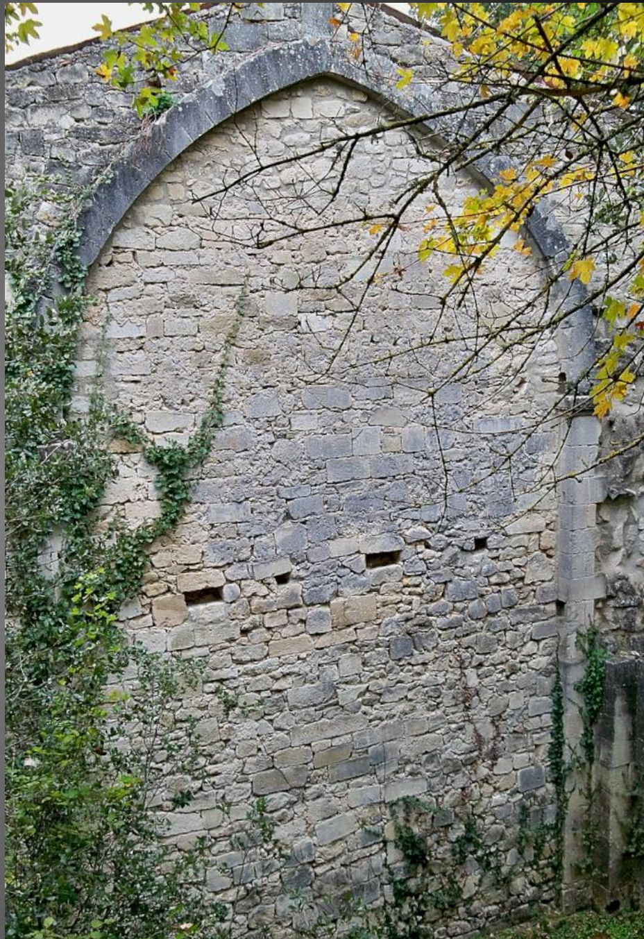
La façade occidentale présente un grand arc ogival.
