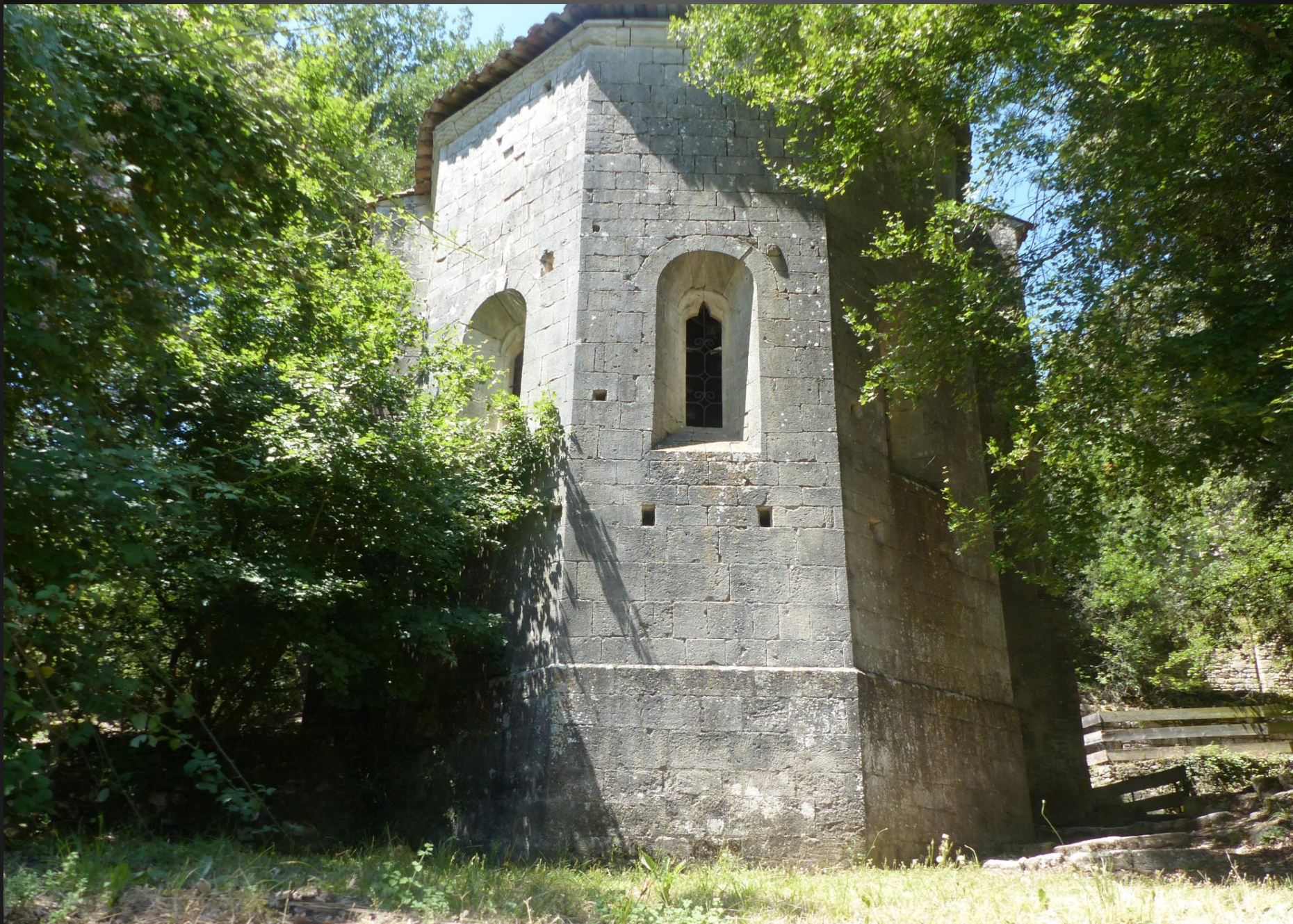
PRIEURÉ DE CARLUC _ La chapelle Notre-Dame est édifiée en pierre de taille assemblée en grand appareil. Le chevet pentagonal est percé de trois fenêtres à simple ébrasement surmontées d'un arc en plein-cintre et est surmonté d'une corniche ornée d'une frise en damier. Sa maçonnerie est percée de nombreux trous de boulin (trous laissés par les échafaudages).
