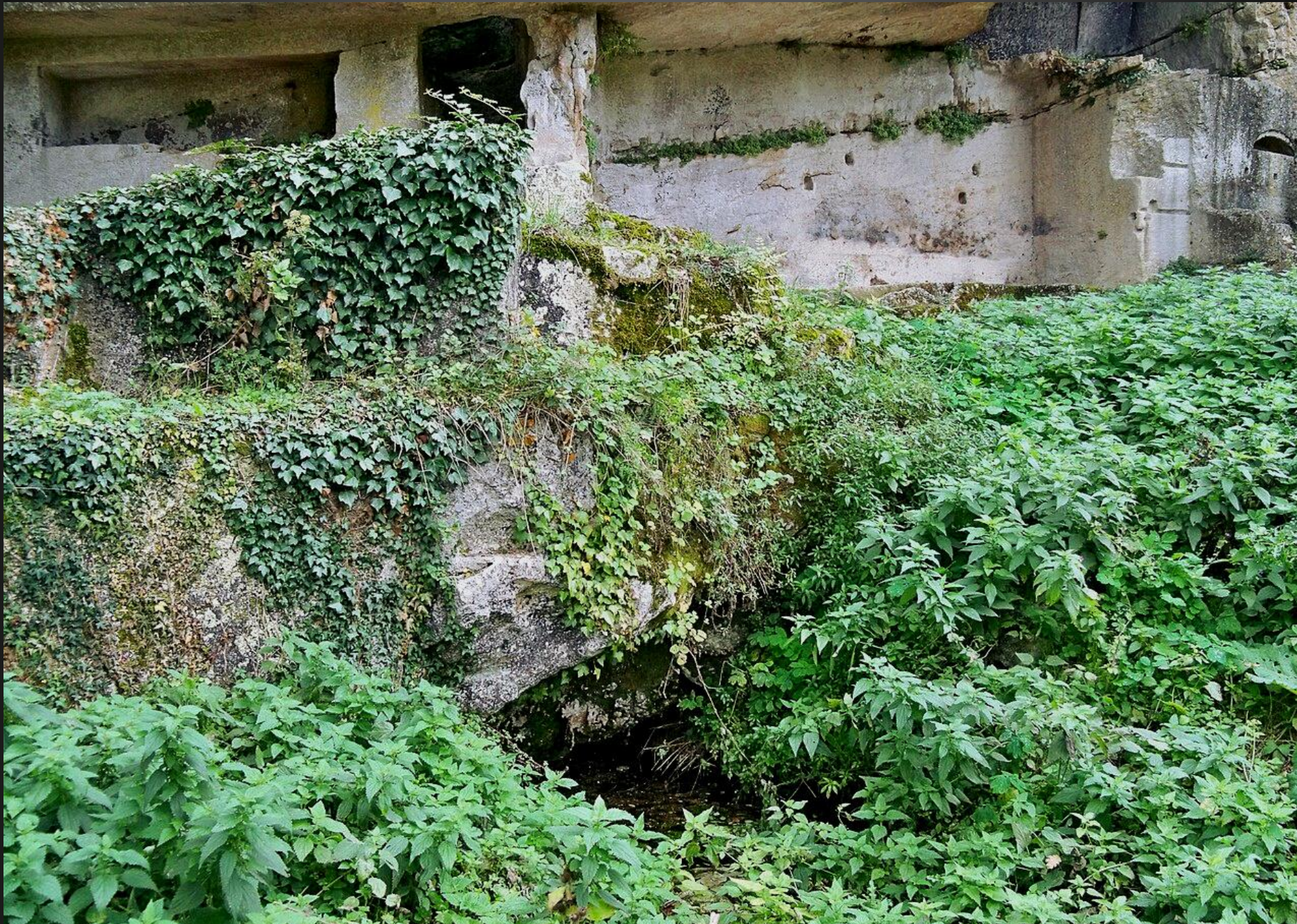
PRIURÉ DE CARLUC _ C'est un lieu de culte sans doute plus que séculaire à l'époque médiévale puisque le priuré jouxte une petite falaise, creusée de galeries, d'habitats rupestres et de tombes anthropomorphiques, au pied de laquelle, sous un portique à colonnes, sourd encore de l'eau de l'ancienne source sacrée qui alimente un petit ruisseau à truite.
