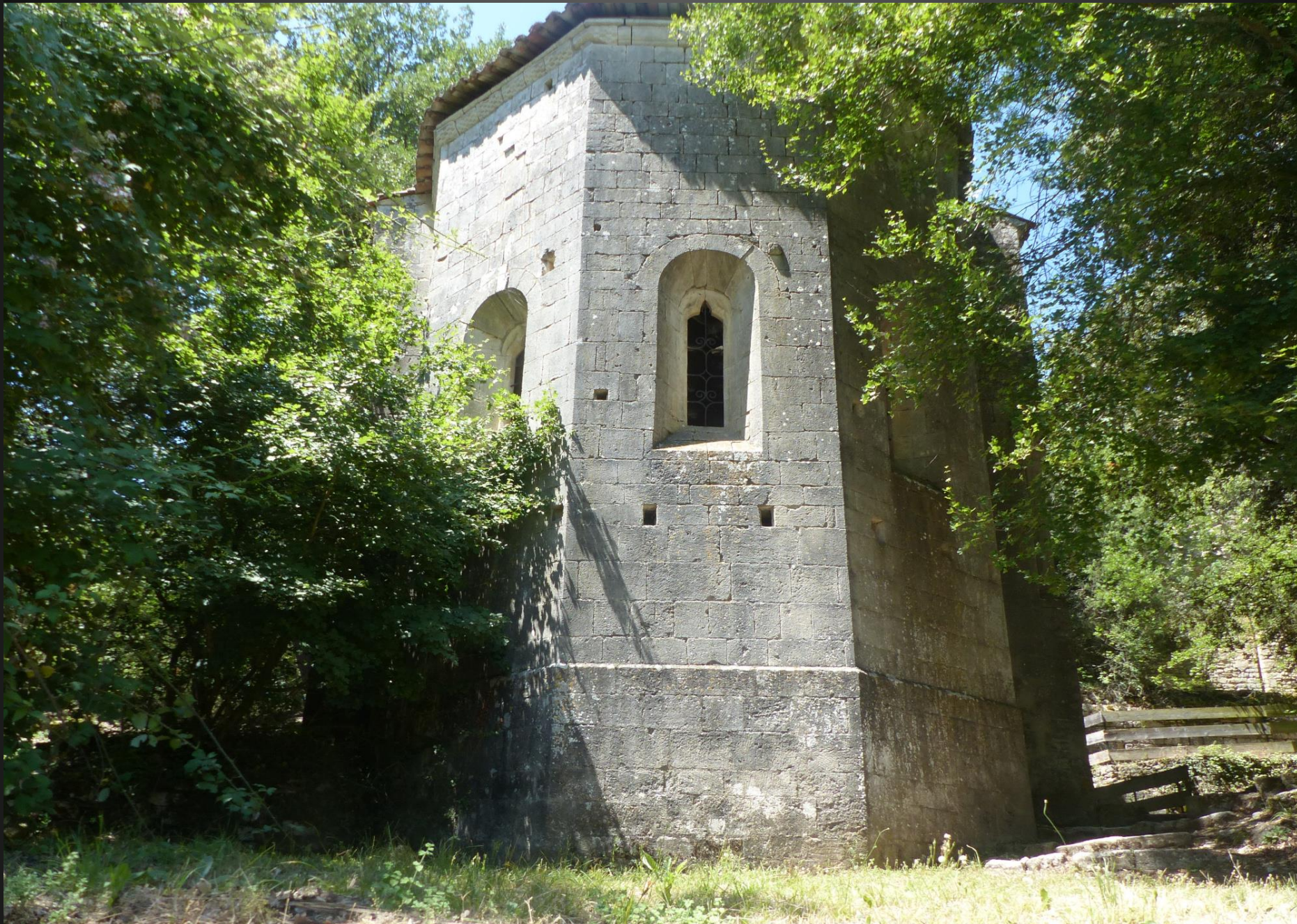
PRIEURÉ DE CARLUC _ La chapelle Notre-Dame est édifiée en pierre de taille assemblée en grand appareil. Le chevet pentagonal est percé de trois fenêtres à simple ébrasement surmontées d'un arc en plein-cintre et est surmonté d'une corniche ornée d'une frise en damier. Sa maçonnerie est percée de nombreux trous de boulin (trous laissés par les échafaudages).
