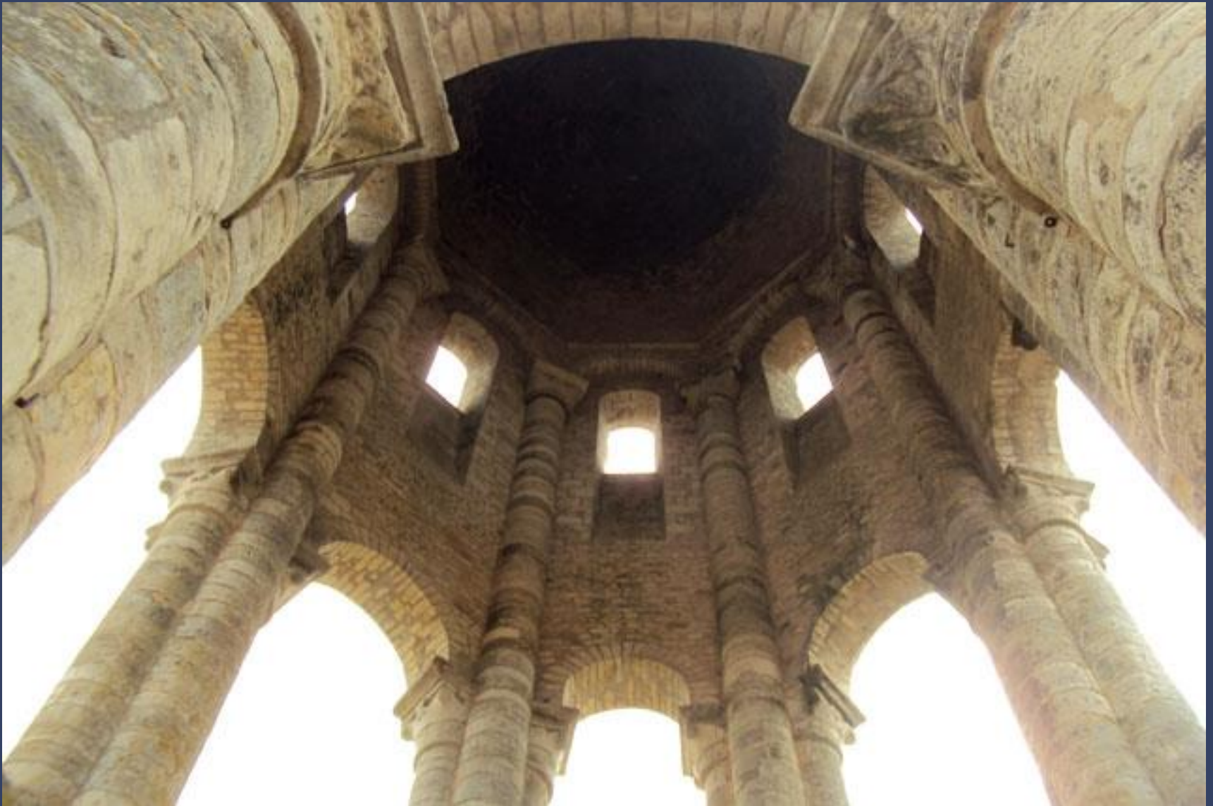
LA TOUR LANTERNE / L'autel majeur était placé au centre, juste au-dessus de la crypte où étaient exposées les reliques. L'élévation montre deux premiers niveaux d'arcades qui se trouvaient à l'origine à l'intérieur de l'église. Les chapiteaux des piliers quadrilobés sont ornés de feuillages gras et d'animaux. La lumière entrant par les fenêtres hautes et éclairait l'autel, d'où son nom de tour lanterne
