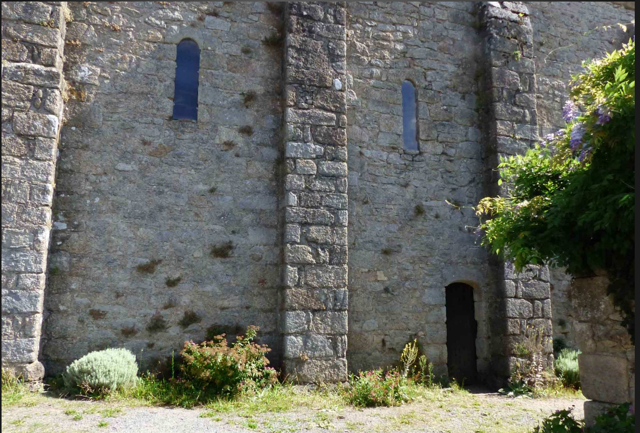
LA CHAPELLE TEMPLIERE DE CLISSON_ De chaque côté, la nef est soutenue par quatre contreforts : l'un d'eux appuie le côté extérieur du pignon qui joint le chœur, et soutient ainsi l'arc triomphal de l'intérieur ; il est placé à 0,28 m avant la saillie de 0,22 m que fait la nef sur le chœur. Ces contreforts, larges de 0,92 m, font sur le mur une saillie qui varie entre 0,31 m et 0,44 m ; entre eux les distances sont de 3,17 m à 3,20 m. Le chœur n'a, de chaque côté, qu'un contrefort, large de 0,92 m et faisant 0,55 m de saillie : entre ce contrefort et la saillie de la nef sur le chœur, on trouve une distance de 3 m ; il est placé à 0,30 m avant la saillie de 0,30 que fait le chœur sur l'abside. Source : http://www.odile-halbert.com/Paroisse/Loireat/Clisson/Clisson.Ch04.pdf
