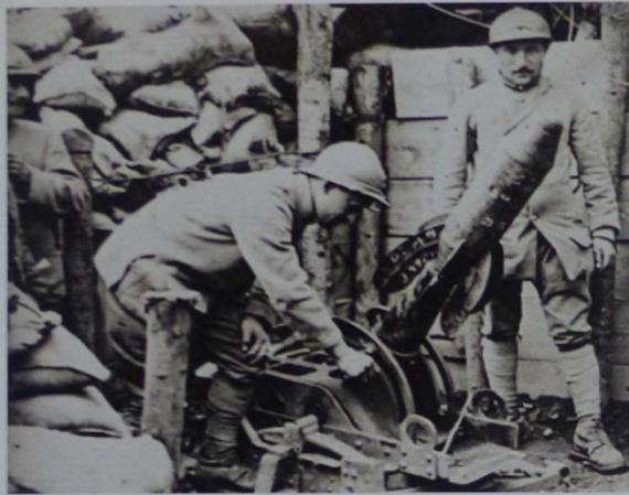
Le mortier présenté est un 58 T N° 2. 58 étant le calibre et T veut dire tranché ; par la suite il est aussi dénommé crapouillot.
