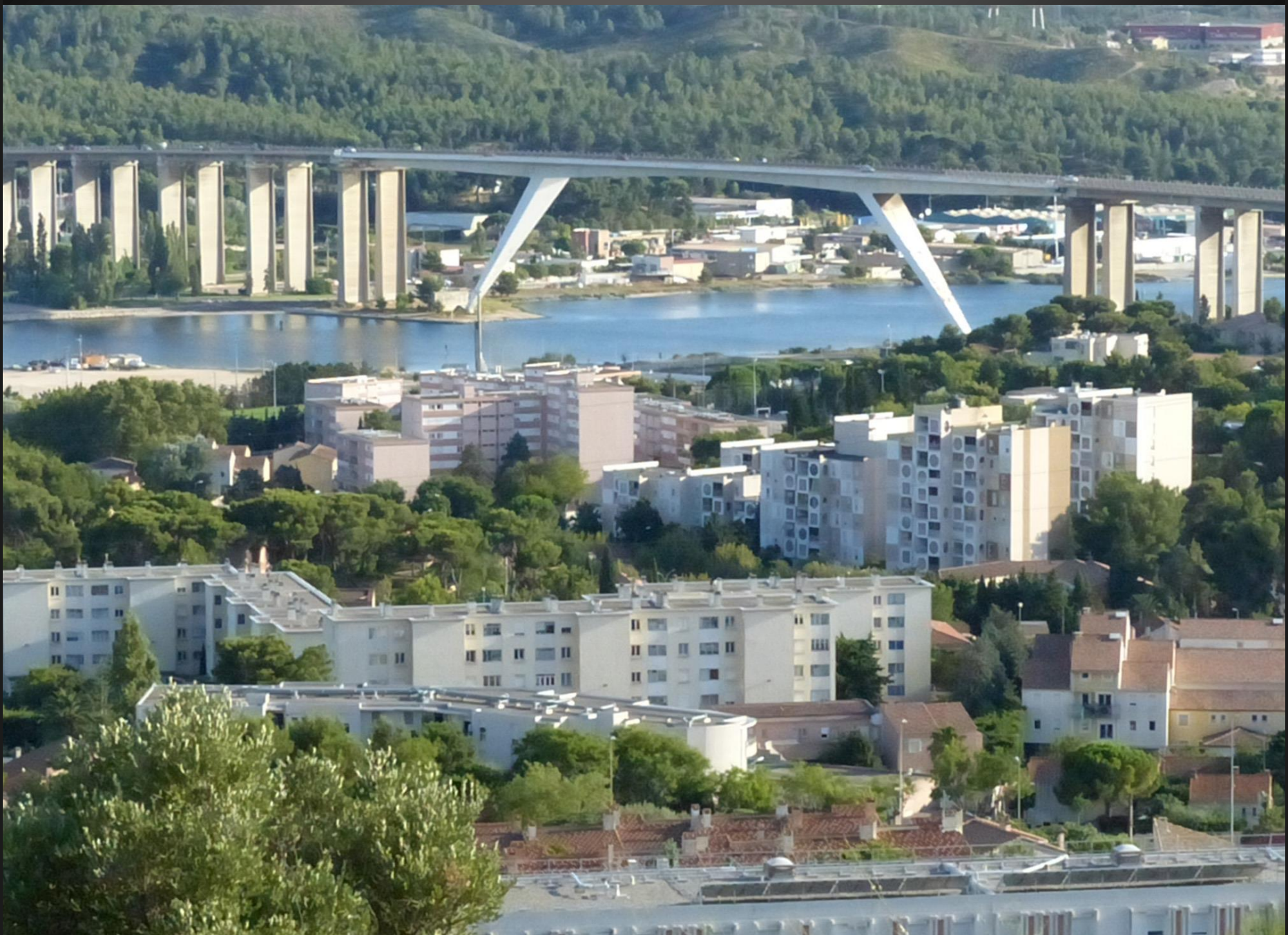
MARTIGUES _ L'imposant viaduc de Caronte.
