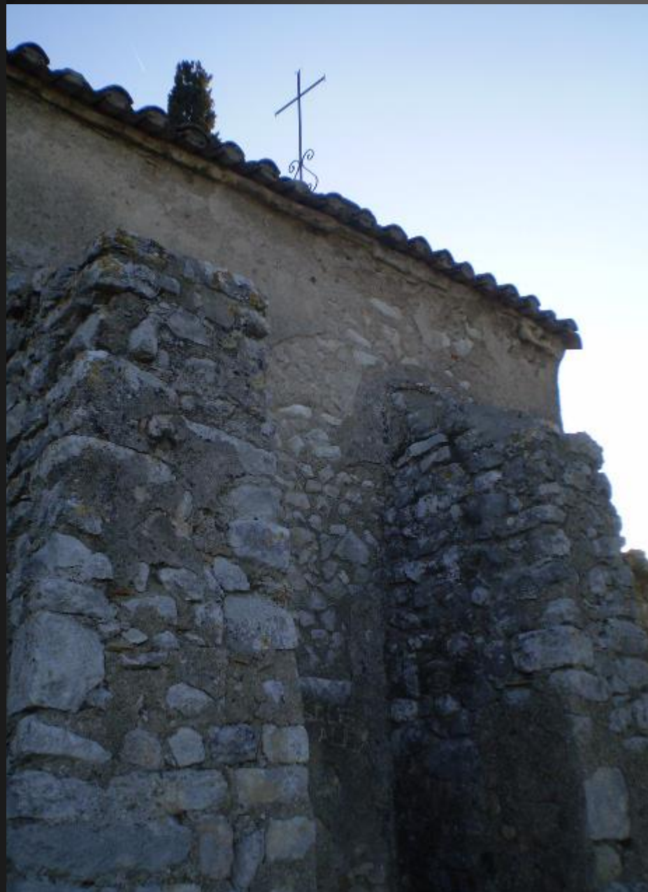
EYGALIERES_ Toute simple, la chapelle Saint-Sixte, construite en moellons, est soutenue par des contreforts massifs.
