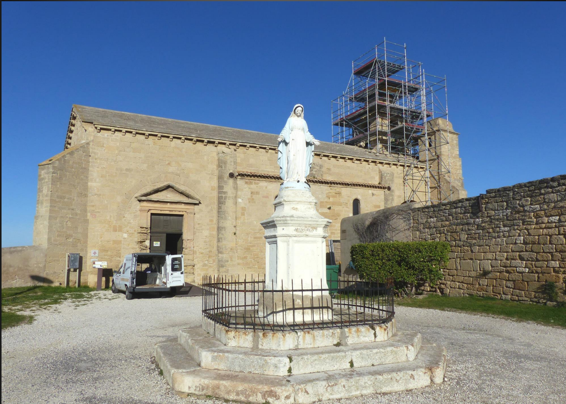
FOS-SUR-MER _ Construite intégralement en calcaire coquillier local, Saint-Sauveur est en élévation une église à deux nefs terminée à l'est par deux chevets à fond plat archaïques, aux soubassements en partie rupestre, datés du Haut Moyen Age (IXe siècle ?).
