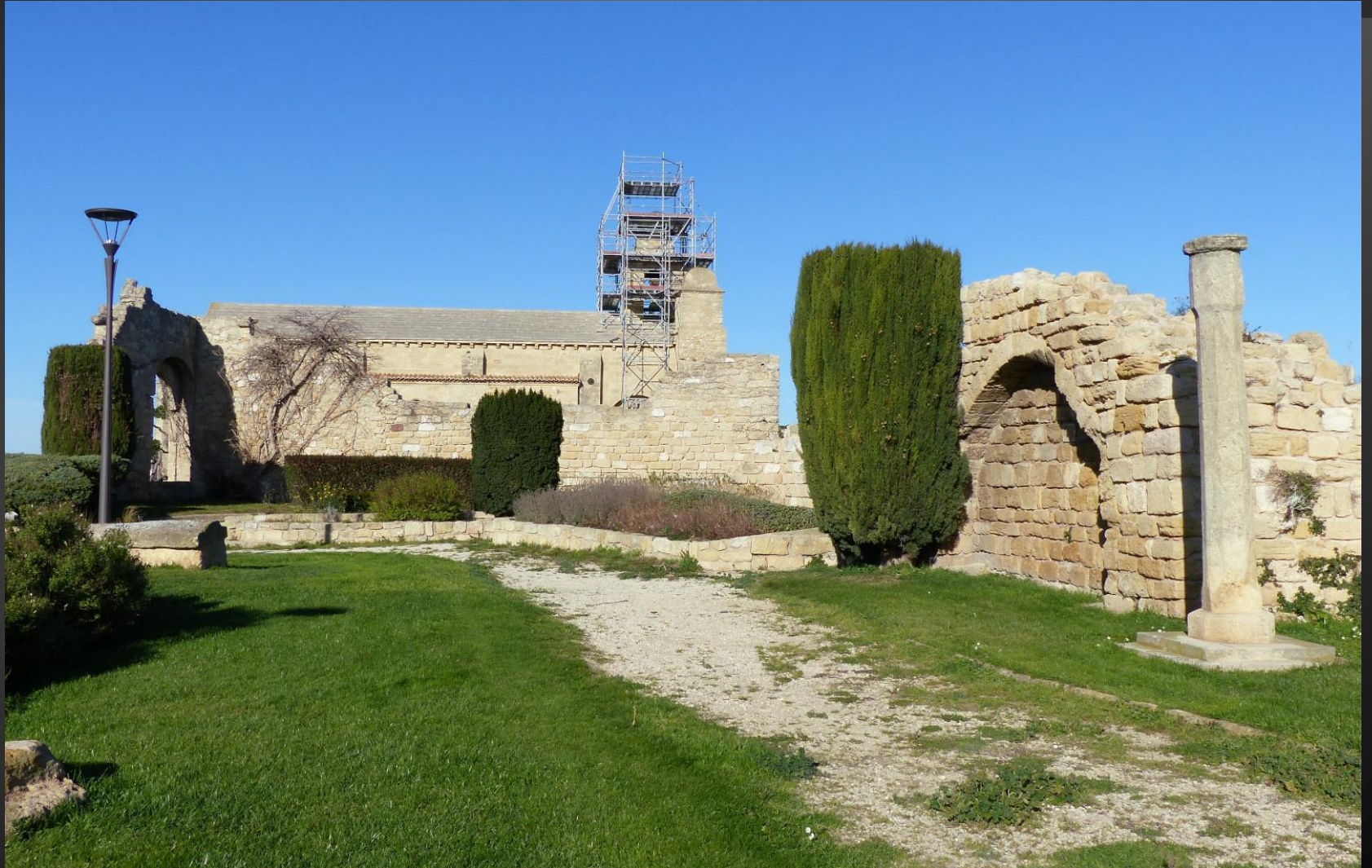
FOS-SUR-MER _ Erigée sur le point culminant (32m), l'église Saint-Sauveur était chargée de protéger la porte du château à proximité, mais aussi le bourg et sa nécropole qui s'étend à ses pieds. Fin 2015, le chantier de rénovation était en cours.
