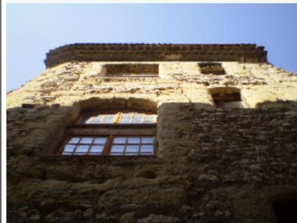
N°4 rue nationale, ancienne maison des co-seigneurs de Fuveau, cinq niveaux... bien remise en valeur par ses propriétaires.
