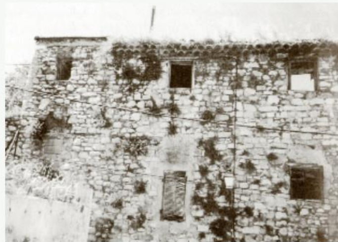
Anciennes constructions en tout venant, pierres mal équarries....
