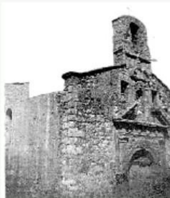
Chapelle des Pénitents à Fuveau, avant sa destruction.
