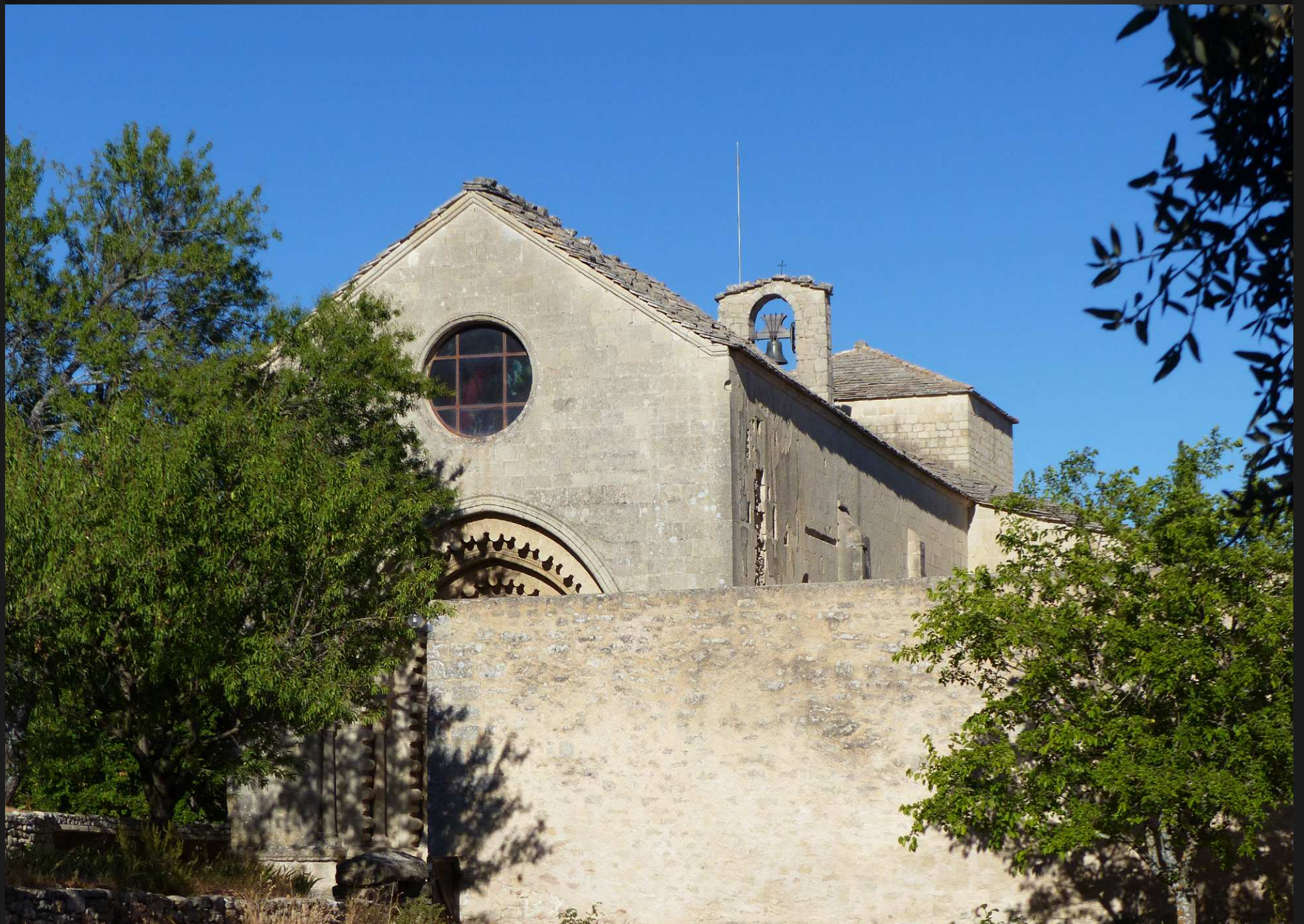
Le sommet du chevet, à la croisée du transept, était à l'origine surmonté d'un clocher de type clunisien, constitué d'une tour octogonale. D'importants vestiges gisent encore dans le petit cimetière proche. La toiture de l'édifice est composée de lauzes ou dalles de pierre, que l'on voit encore sur certaines chapelles romanes du XI-XIIe siècles.
