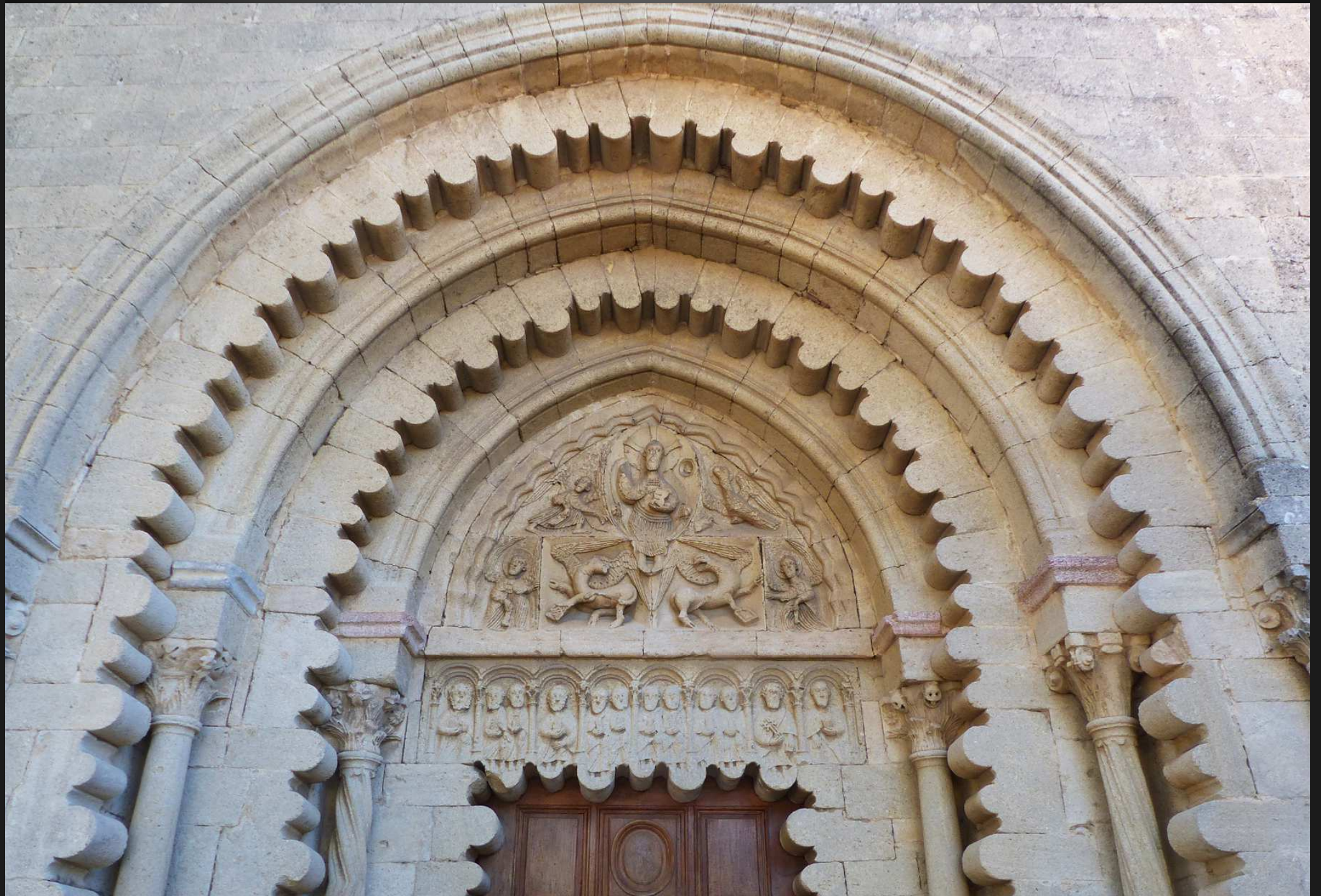
Le portail, ayant subi plusieurs restaurations vers le XVIe ou plus sûrement vers le XVIIIe siècle, se compose d'une archivolte où les voussures pleines sont associées à des voussures festonnées retombant sur des colonnettes de chaque côté, et prenant appui sur un bahut constitué de cinq socles moulurés. Ces colonnettes sont rehaussées de chapiteaux corinthiens à feuilles d'acanthé, tous différents. L'arc festonné brisé est apparu au XIIe siècle dans l'architecture de transition roman-gothique française le long de la Via Francigena qui prolongeait la Via Tolosane jusqu'à Turin. Deux des cinq voussures de ce portail sont ornées de festons de deux tailles différentes. La porte elle-même est encadrée de festons, lesquels sont intégrés au linteau. (wikipedia)
