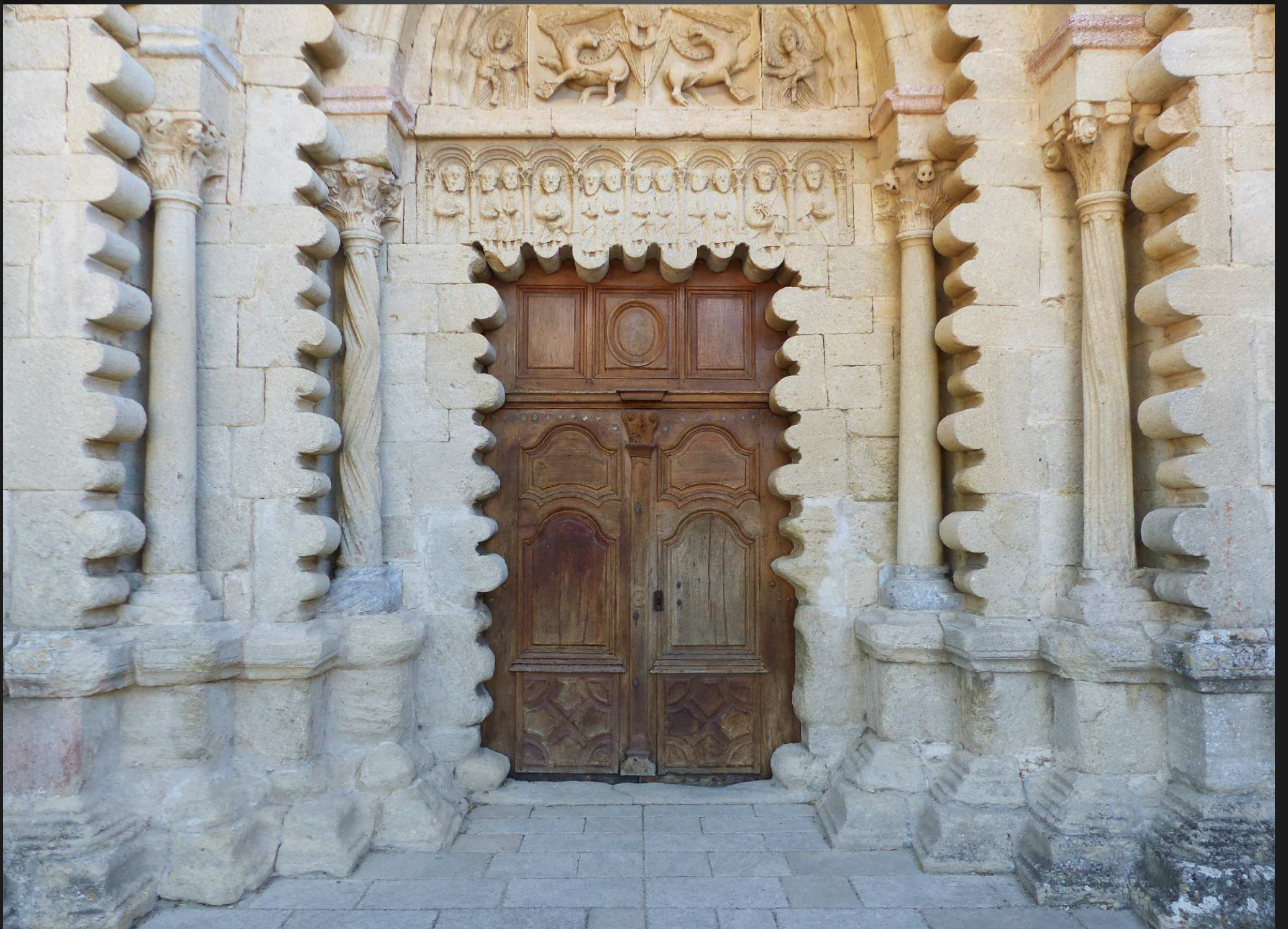
Les colonnettes de chaque côté prennent appui sur un bahut constitué de cinq socles moulurés, devant lequel les visiteurs aiment à se faire prendre en photo ...
