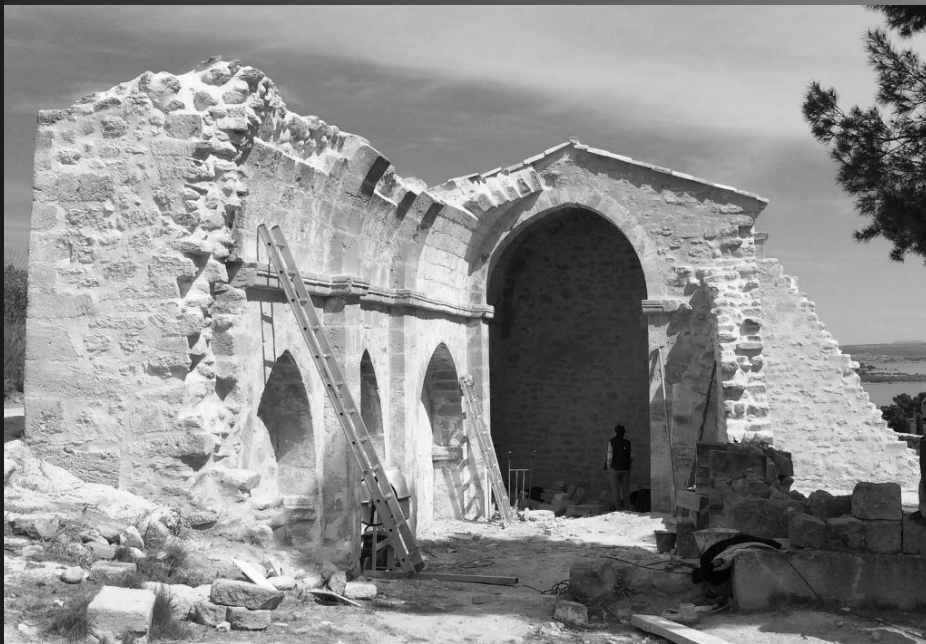
Chapelle Saint-Etienne _ Chantier de restauration, du 06 jan au 30 avr 2016, pour sauver de la ruine les restes de cette petite chapelle. Techniques utilisées : – Etalement par contrefort en bois des faces Sud et Est du Chœur – Dépose et repose de l’arc doubleau entre la nef et le Chœur – Dépose et repose à 50% du parement extérieur du mur Sud du Chœur – Réalisation à neuf d’une toiture en tuiles canal sur mortier de chaux – Reprise des joints et réfection des arases de mur. Source : https://www.sele.fr/fr/chapelle-saint-etienne-istres
