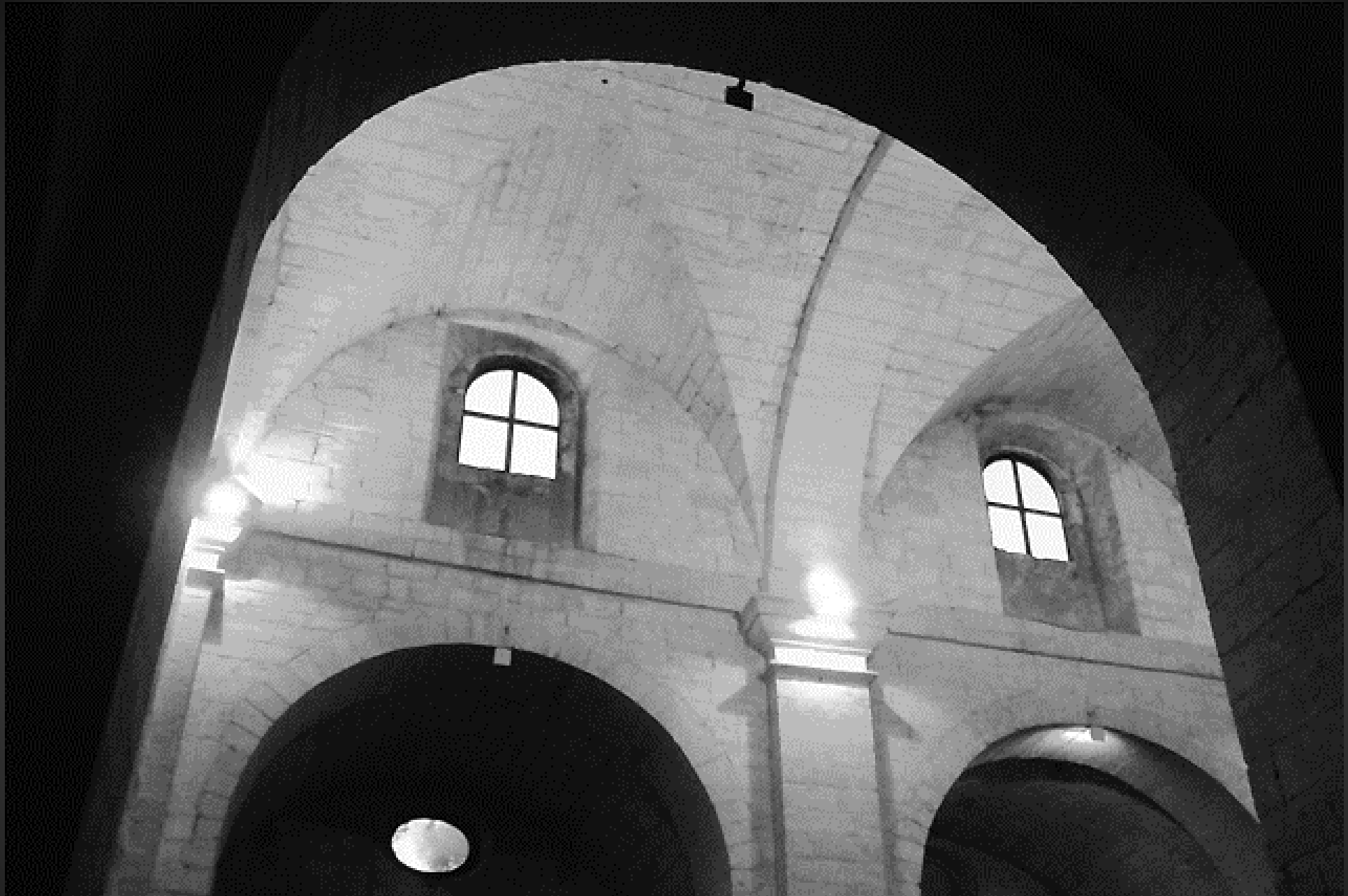
Eglise Notre-Dame-de-Beauvoir (XIIIe s.) _ Arches en plein cintre entre les collatéraux et la nef, bel exemple d'art roman. La nef, effondrée en 1708, fut reconstruite en 1720. Le clocher primitif, construit selon la tradition romane au dessus du chœur à la croisée de la nef et du transept, s'écroula sur l'autel en 1788, puis à nouveau en 1831, et encore une fois en 1835 : pour plus de sécurité il fut reconstruit à l'extérieur de l'édifice en 1837. Les orgues, dont le buffet en noyer évoque ceux d'Isnard au XVIIIe siècle, furent installés en 1843.
