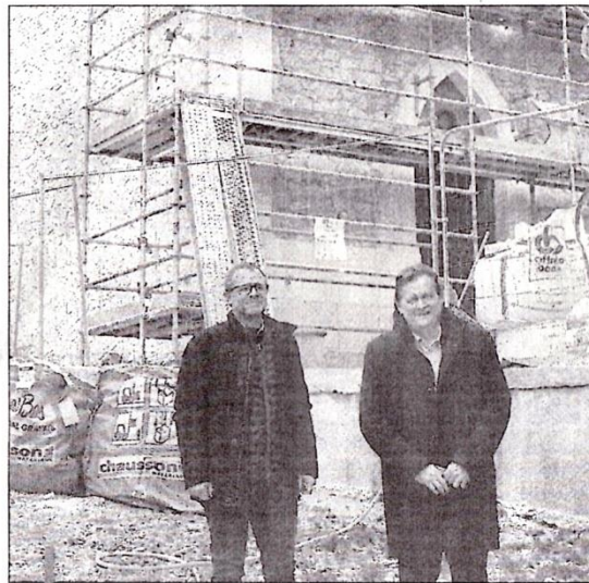
La chapelle fait actuellement l'objet d'un chantier de rénovation.
