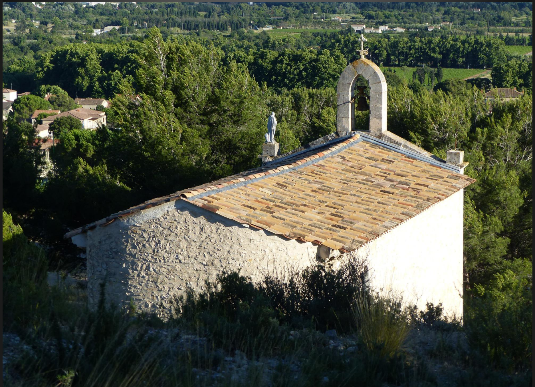
Chapelle Sainte-Rosalie _ La charpente et la toiture de la chapelle ont été entièrement refaites en 2012 pour protéger l'édifice des infiltrations d'eau.
