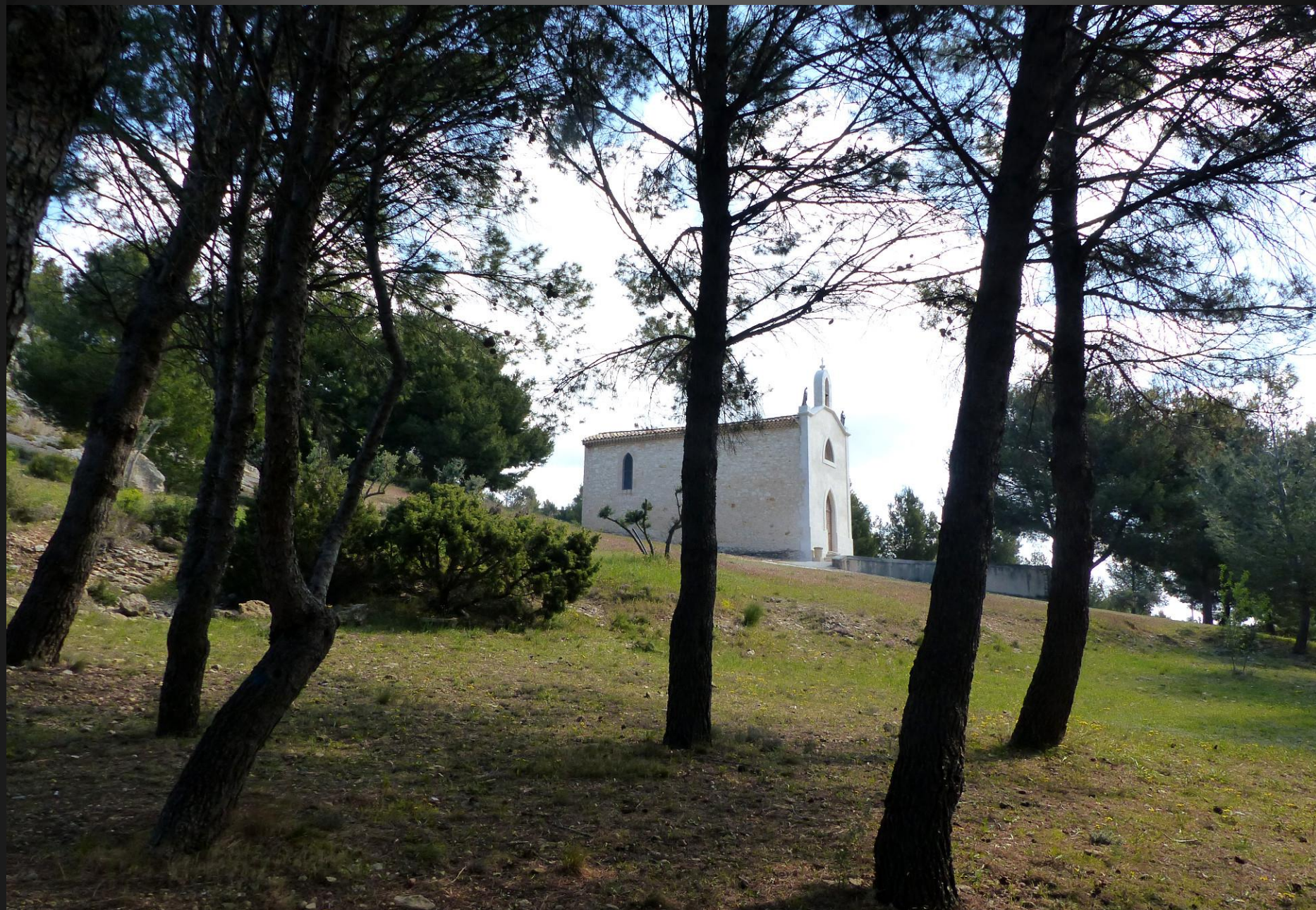
La Fare-les-Oliviers _ La chapelle fraîchement rénovée apparaît toute blanche entre les pins sombres, à flanc de colline.
