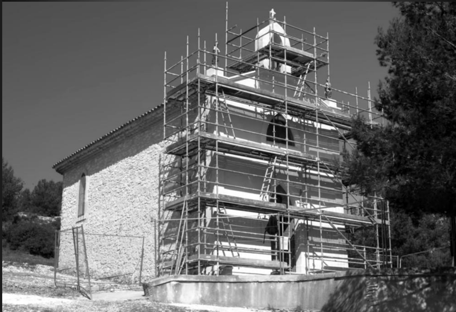
Rénovation de la chapelle Sainte-Rosalie _ l'Echafaudage pendant le chantier... La chapelle, qui traverse le temps depuis 160 années, a déjà fait l'objet de rénovations avec notamment la restauration de la charpente et de la toiture en 2012. Cependant, l'humidité menaçait sa structure, ainsi la façade et les enduits extérieurs ayant été entièrement rénovés, la chapelle sera maintenant protégée des eaux de ruissellement et des remontées d'humidité. D'autres désordres dus aux affres du temps ont été décelés, tels la détérioration des vitraux et le degré d'usure du mécanisme soutenant la cloche : ces éléments ont également été restaurés. (Source : La Mantesada , le magazine de La Fare-les-Oliviers, avril 2021, pp.12-13)
