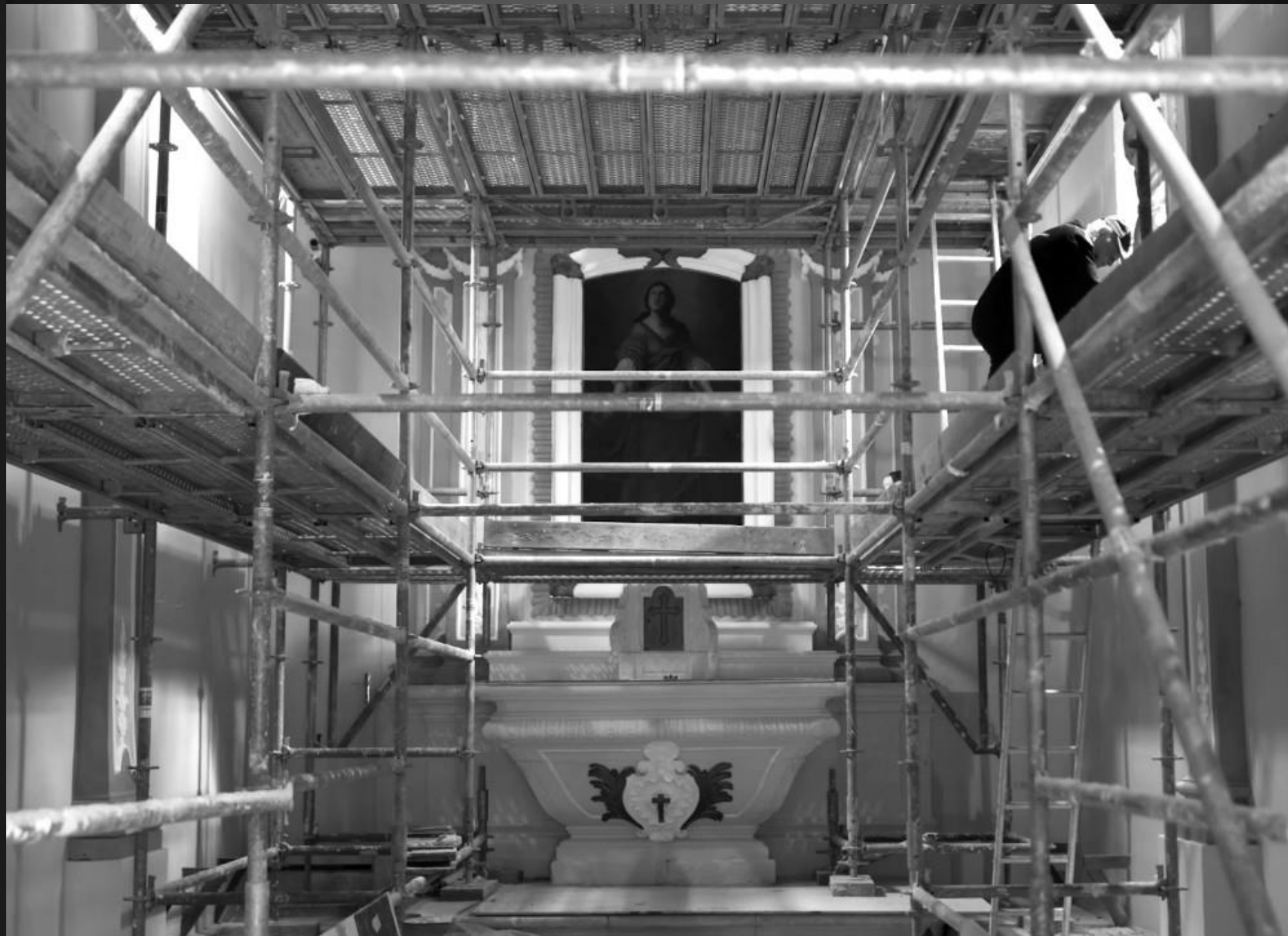
Rénovation de la chapelle Sainte-Rosalie _ Le revêtement et la décoration des murs intérieurs, abimés par l'humidité, ont été restaurés.
