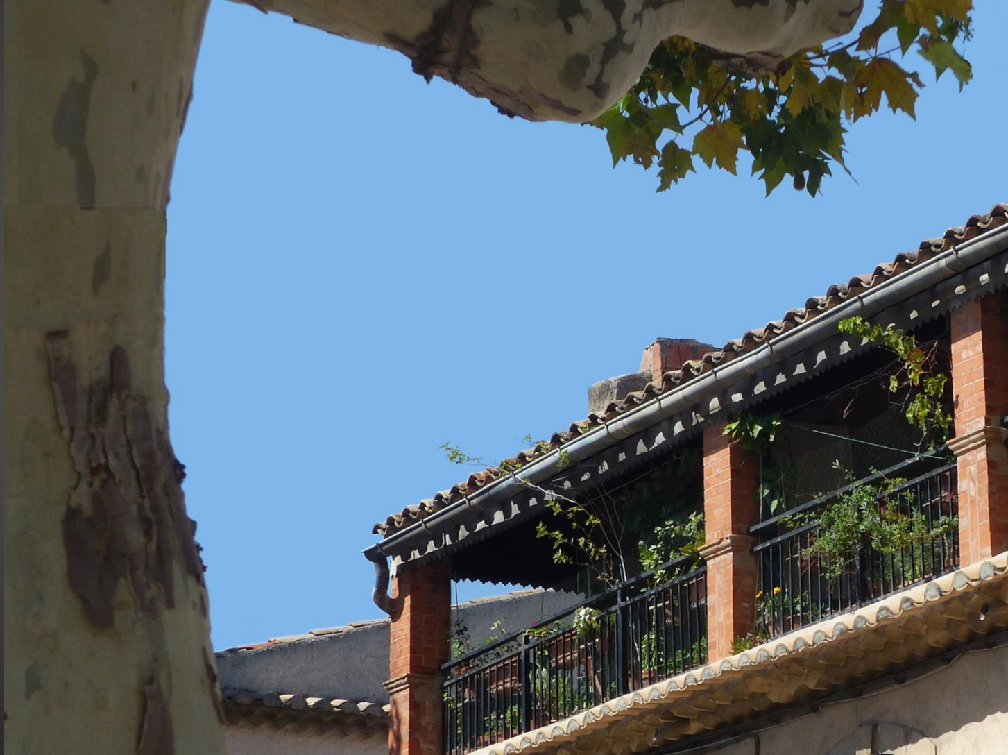
LA FARE Le balcon du Presbytère
