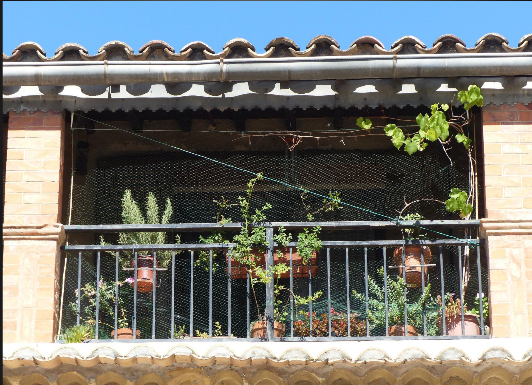
Le balcon, partie centrale.
