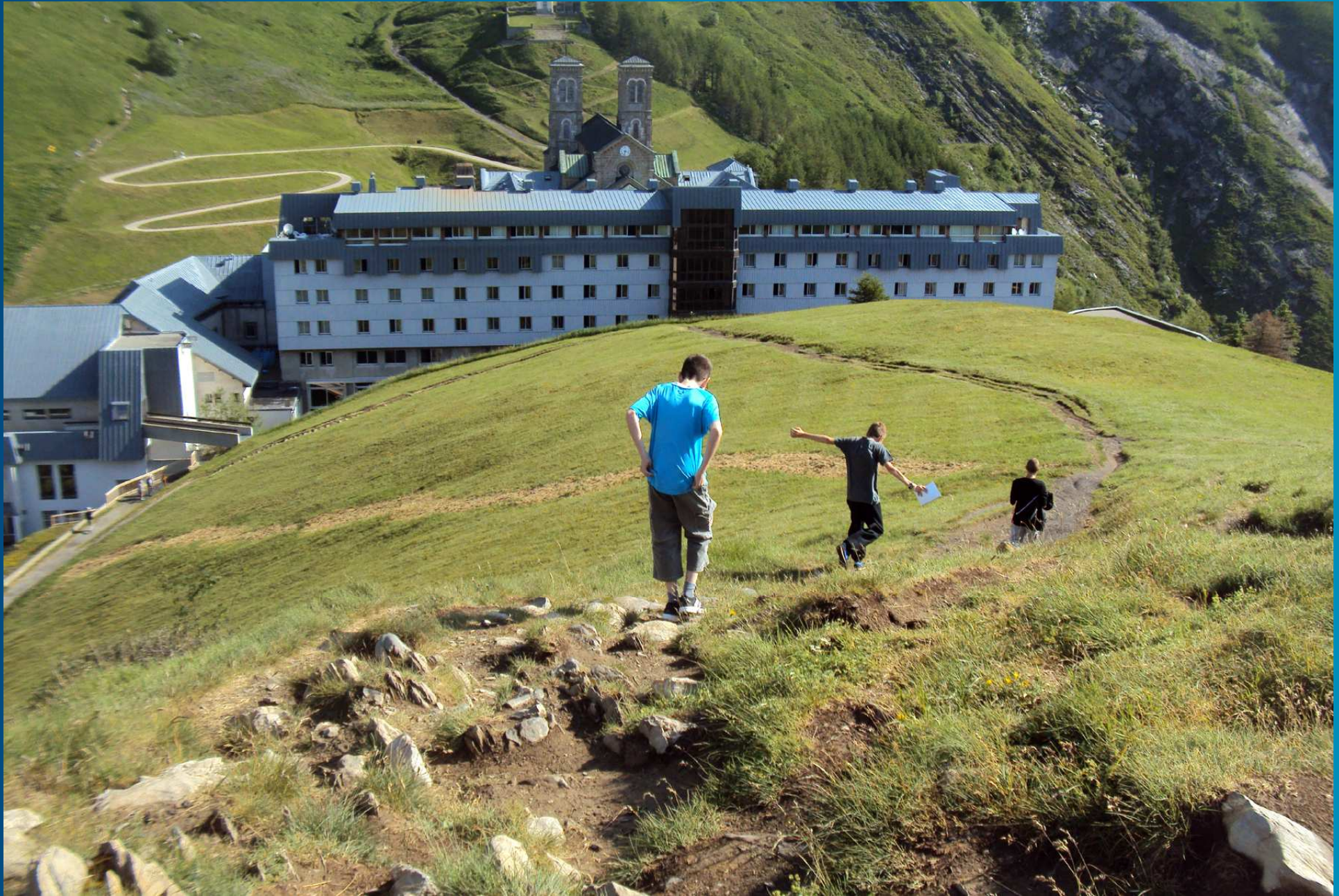
L'HOTELLERIE _ Vue depuis le Plateau, les vastes bâtiments , qui semblent enserrer la basilique , peuvent accueillir des centaines de pèlerins et les protéger de la rigueur de l'hiver à cette altitude.
