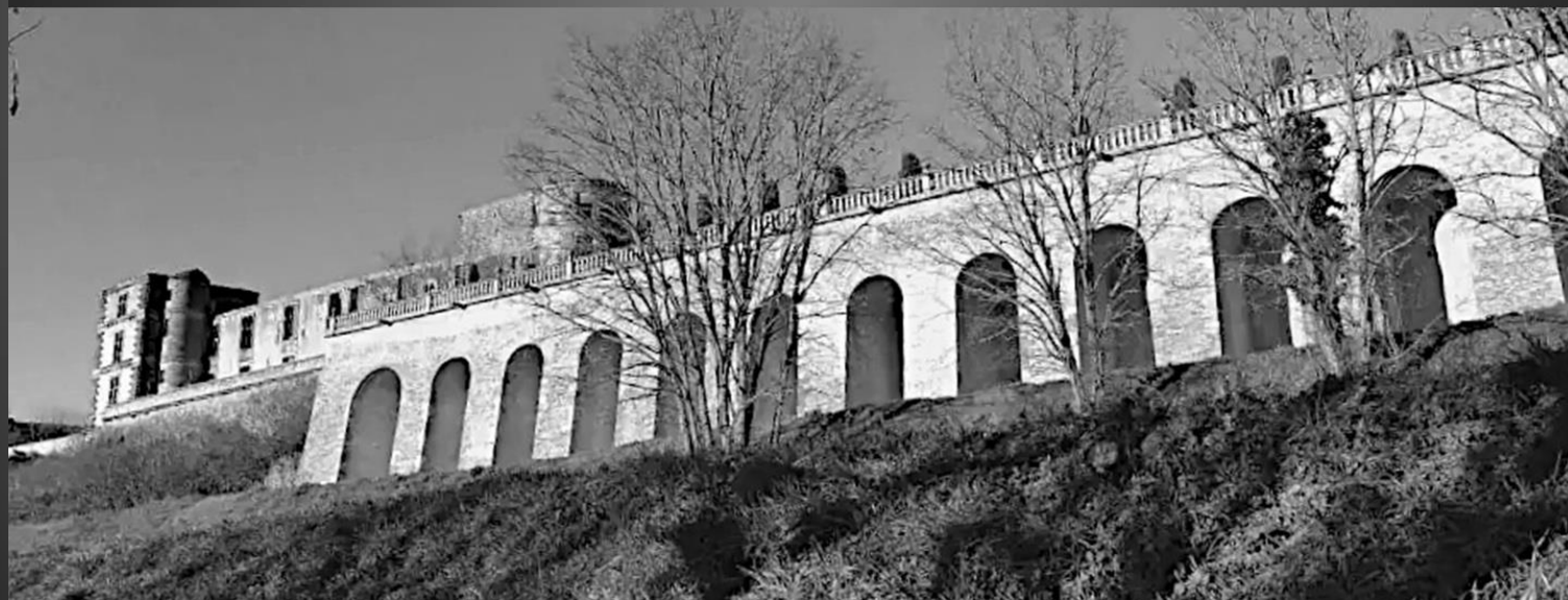
LA TOUR D'AIGUES _ Vue panoramique du village et du château.
