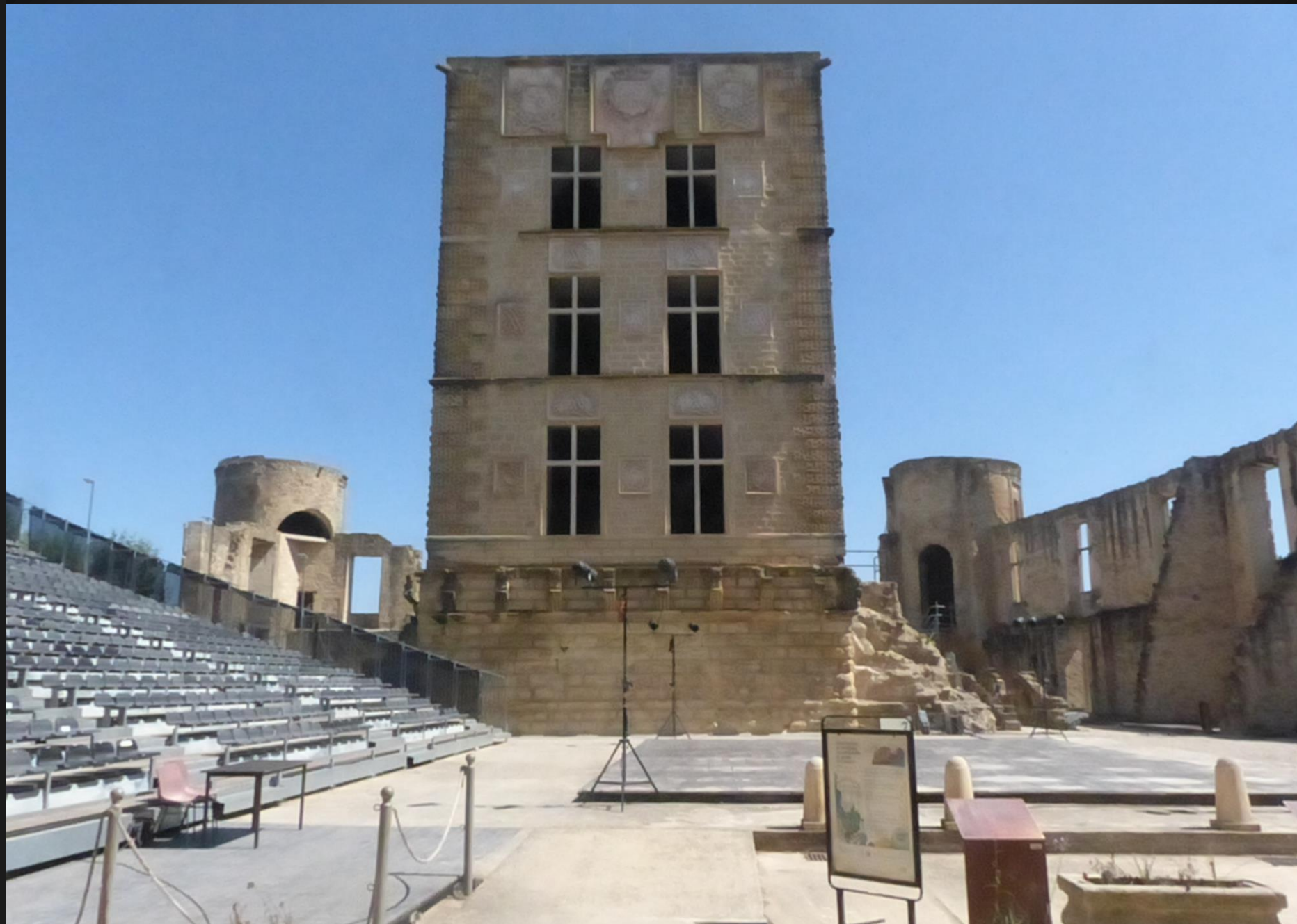
LA TOUR D'AIGUES _ Récemment, les trois niveaux du donjon ont été restitués et sa façade, jusque-là éventrée, a été réhabilitée. Depuis 1986, des expositions et des spectacles ont lieu dans les salles aménagées au sous-sol. Un festival d'été se déroule dans la Cour d'honneur.
