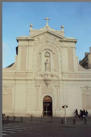
La façade de l'église, sur le Vieux Port, a été récemment rénovée.
