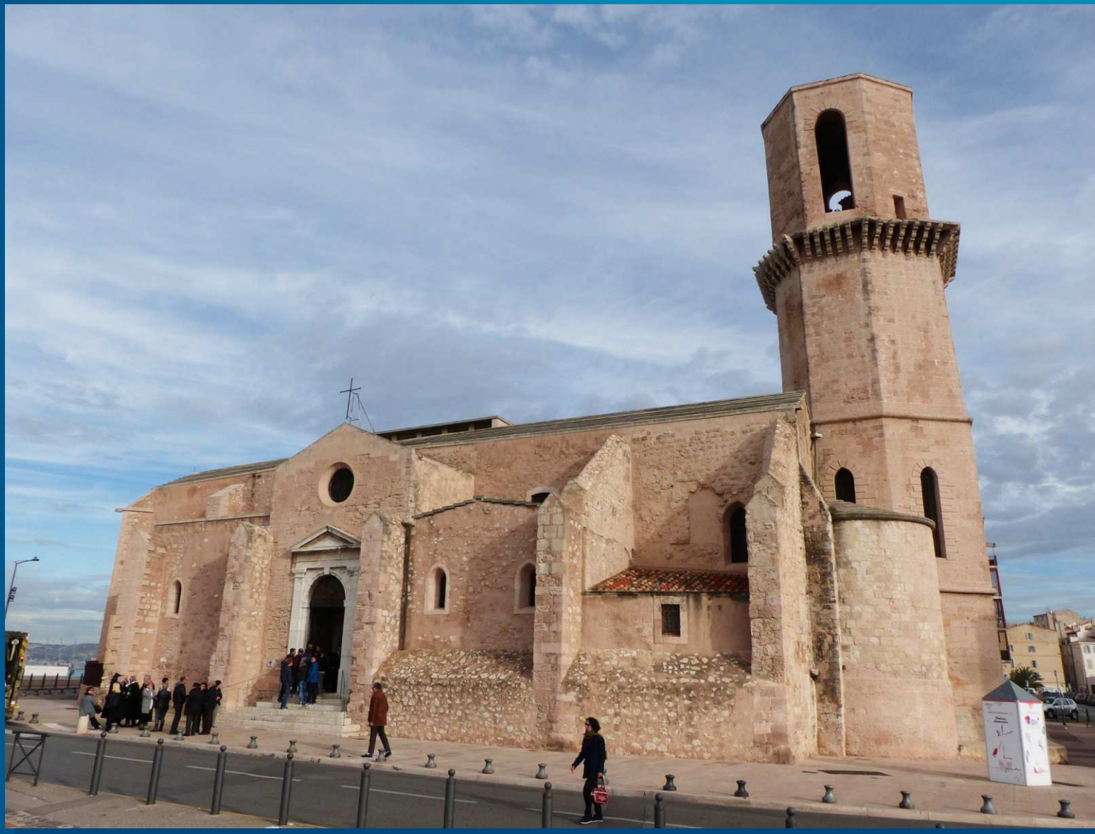
MARSEILLE 13 NOV 2016 _ L'église Saint-Laurent (XIIe siècle, roman provençal, classée MH 1921).
