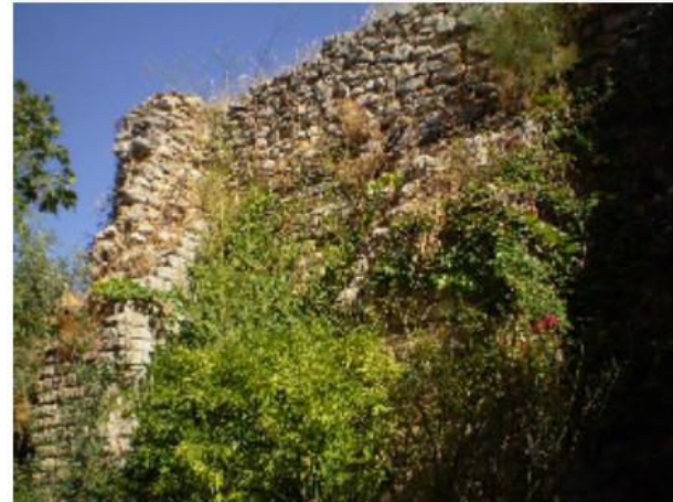
Le mur est impressionnant: long de 18 mètres, épais de 2 mètres, il est renforcé par plusieurs contreforts, qu'on distingue nettement sur la photo du bas: espacés de 2m20, hauts de 3m, de profil trapézoïdal et de base carrée de 1m de côté, ils sont au nombre de trois, qui soutiennent ...
