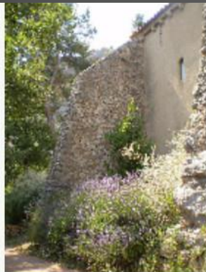
Les deux puissants contreforts sur la face Sud, datent de 1832.
