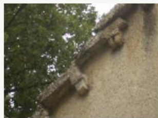
L'assemblage des lauzes formait une bordure de couverture rarissime dans la région, typique des plus anciennes chapelles de Provence
