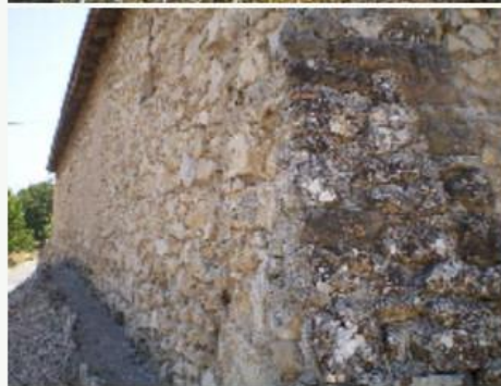
Le contrefort a été consolidé par les propriétaires, qui confirment l'existence de cette construction bien avant l'époque du Roi René, probablement au XIVe siècle..
