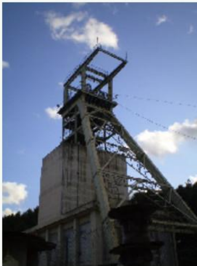
Puits Gérard, à Mimet: 730 mètres de profondeur, 6 mètres de diamètre.
