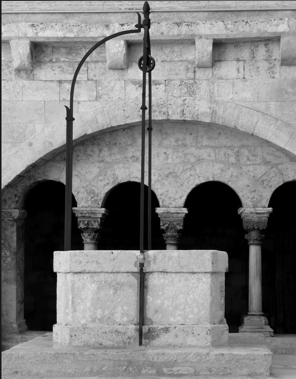
Galerie SUD: Quadruple arcature de la galerie sud. Une citerne, accessible par un puits, recueille l'eau de pluie collectée par l'impluvium formé grâce à des dalles de toiture imbriquées. (Images du Web)
