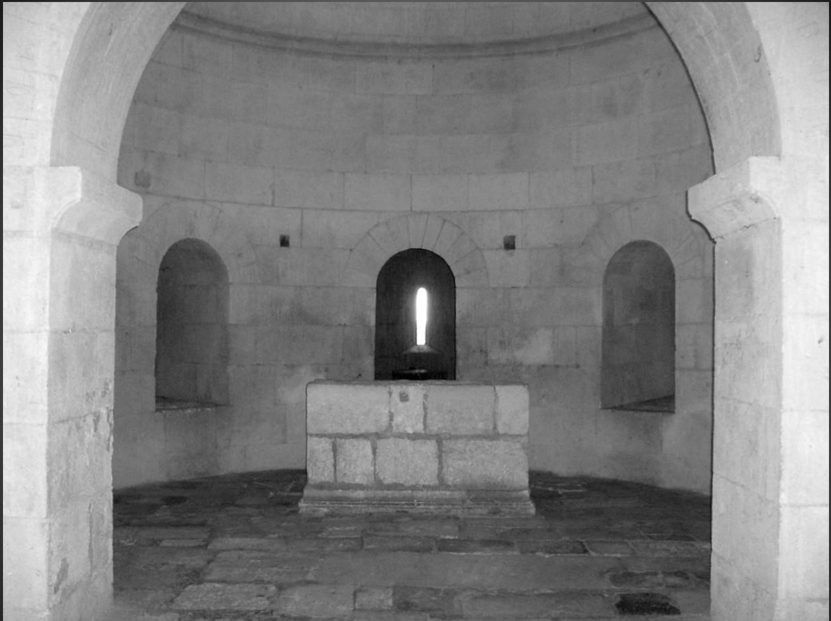
ABBAYE DE MONTMAJOUR _ La rotonde de la crypte Saint-Benoît. Dans toute cette église basse, on ne peut qu'admirer l'extrême qualité de l'appareillage, avec la finesse des layages, ses tailles pointillées ou en feuilles de fougère ; mais c'est surtout dans le transept que s'impose un art de bâtir hérité du mode de construction des grands monuments gallo-romains provençaux. Du côté sud ce transept a été creusé dans la roche dont le front de taille est resté brut sur les parois, alors qu'au nord il repose sur de massives fondations, accrochées au flanc de la colline, remarquables par la spectaculaire inégalité de largeur des quatre arcs-doubleaux supportant les voûtes. Leur épaisseur croit, en effet, de façon importante depuis le sud où le premier, ancré directement dans le roc, n'a qu'un mètre de large, jusqu'au quatrième, à l'extrême nord, qui atteint trois mètres quatre-vingts. ( Image du Web )
