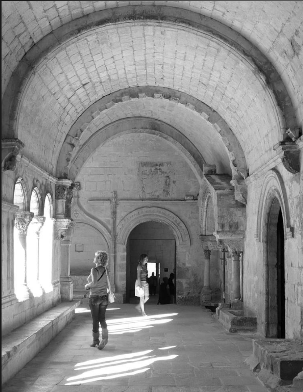
Galerie EST : voûte en berceau et arcs-doubleaux délimitant les travées. (Image du Web)
