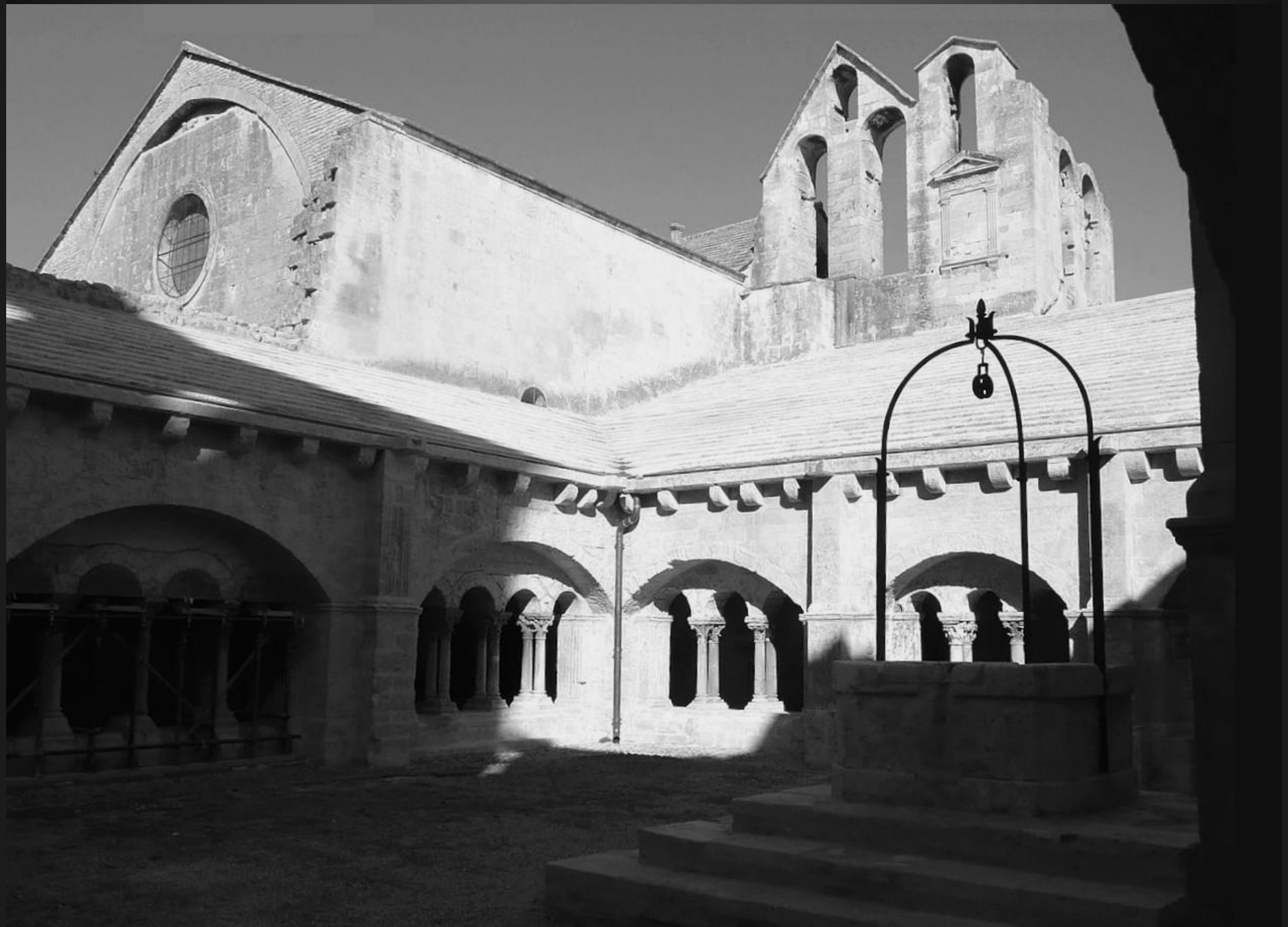
LE CLOITRE : Jeu d'ombres et de lumière s à l'angle sud-est avec, à l'arrière, l'abbatiale.
