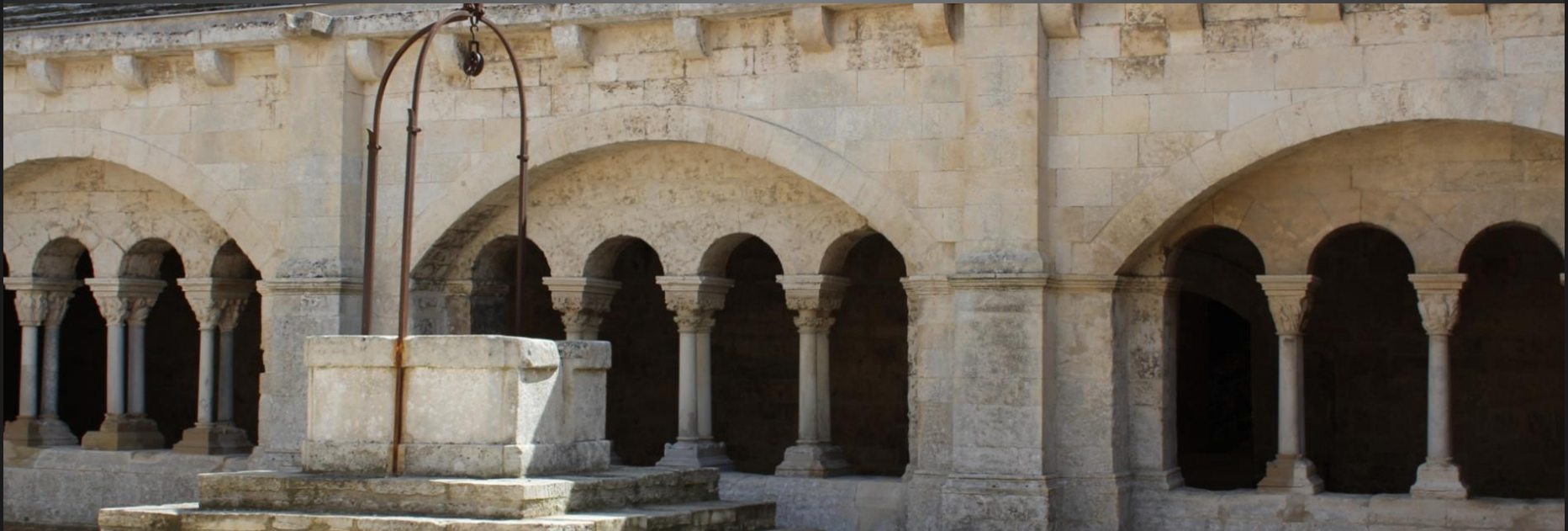
LE CLOITRE _ Voûte en berceau et arcs-doubleaux délimitant les travées, baies à triple et quadruple arcature, colonnes géminées. Assurément l'un des plus beaux cloîtres romans de Provence (XIIe s). (Images du Web)
