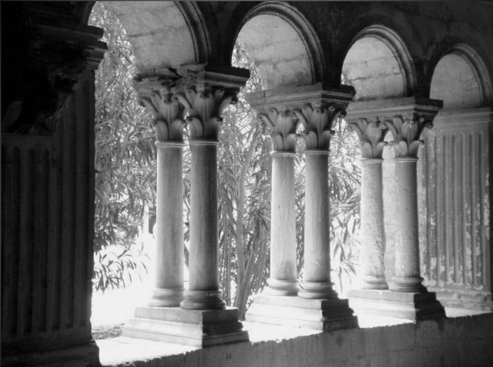
Galerie SUD : baie à quadruple arcature, colonnes géminées. De construction plus récente, cette galerie conserve une structure romane mais diffère des autres par ses éléments décoratifs. Les consoles arborent un bestiaire plus réaliste : âne, singe, dromadaire, aigle ; les arcs-doubleaux d'angle retombent sur des colonnes dont le fût porte une bague ; les chapiteaux décorés de feuilles de chou ou historiés sont taillés deux par deux dans un même bloc de pierre, et datent de la deuxième moitié du XIV e s., probablement contemporains du bâtisseur de la tour-donjon, l'abbé Pons de l'Orme, moine de l'abbaye marseillaise Saint-Victor.
