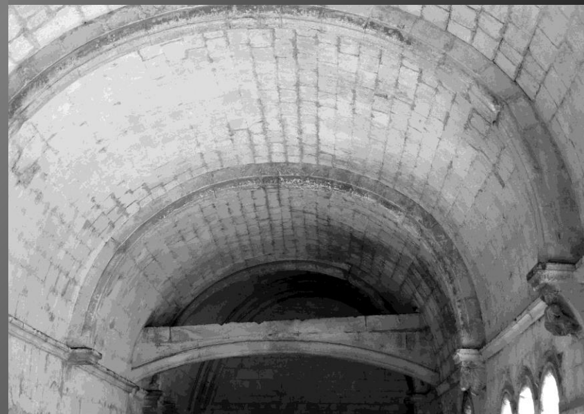
La voûte de la travée la plus méridionale est traversée par un curieux arc (XIV e siècle) sans fonction porteuse, creusé d'une gouttière, et qui est en fait un petit aqueduc conduisant une partie de l'eau recueillie par l'impluvium vers une citerne extérieure près de la tour-donjon.
