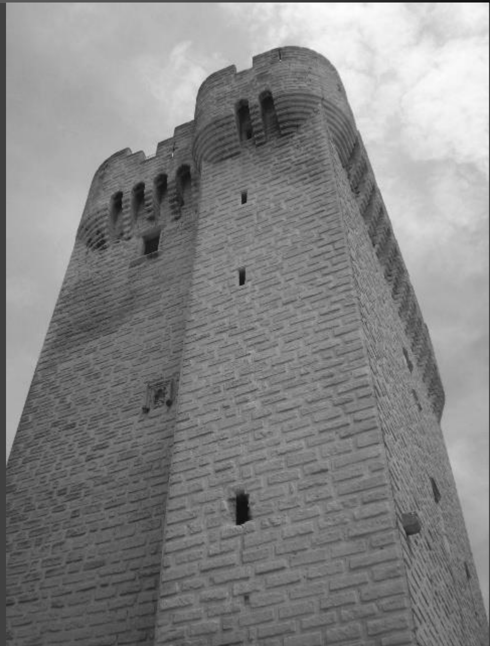
LA TOUR Pons de l'Orme_ Véritable donjon, c'est une tour appareillée en bossages, de 26 mètres de haut, sur plan barlong avec ressaut à l'ouest correspondant à l'escalier à vis desservant les différents niveaux.
