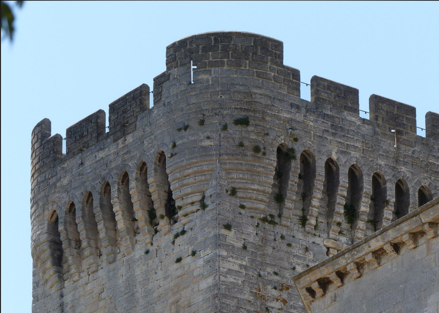
LA TOUR _ La terrasse de la Tour dite de Pons de l'Orme, est défendue par un crénelage à mâchicoulis (restauré en 1946), lui-même supporté par des consoles à ressaut, les angles étant renforcés par des ouvrages courbes en encorbellement percés d'archères. ( https://fr.wikipedia.org/wiki/Abbaye_de_Montmajour )
