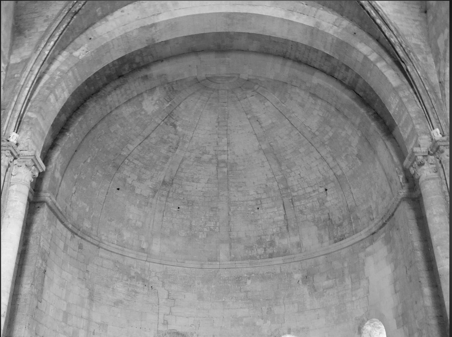
L'ABSIDE _ La couverture en cul-de-four de l'abside est magnifiquement appareillée et sous-tendue par cinq nervures très plates issues du cordon de la naissance de la voûte et s'amortissant en demi-cercle contre le bandeau de la travée du chœur. ( Image du Web )
