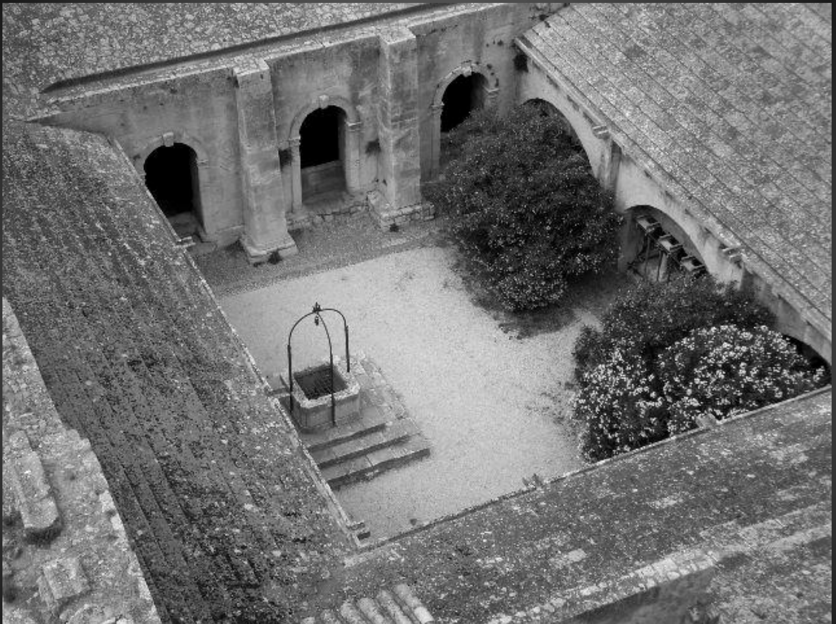
LE CLOITRE _ La galerie OUEST, profondément remaniée au XVIII e siècle afin de pouvoir supporter les deux étages prévus par la reconstruction mauriste, a perdu sa belle façade sur cour. Trois hautes fenêtres encadrées de massifs piliers fortifiés par des contreforts extérieurs ont remplacé es trois baies à triple arcature sur colonnettes géminées.
