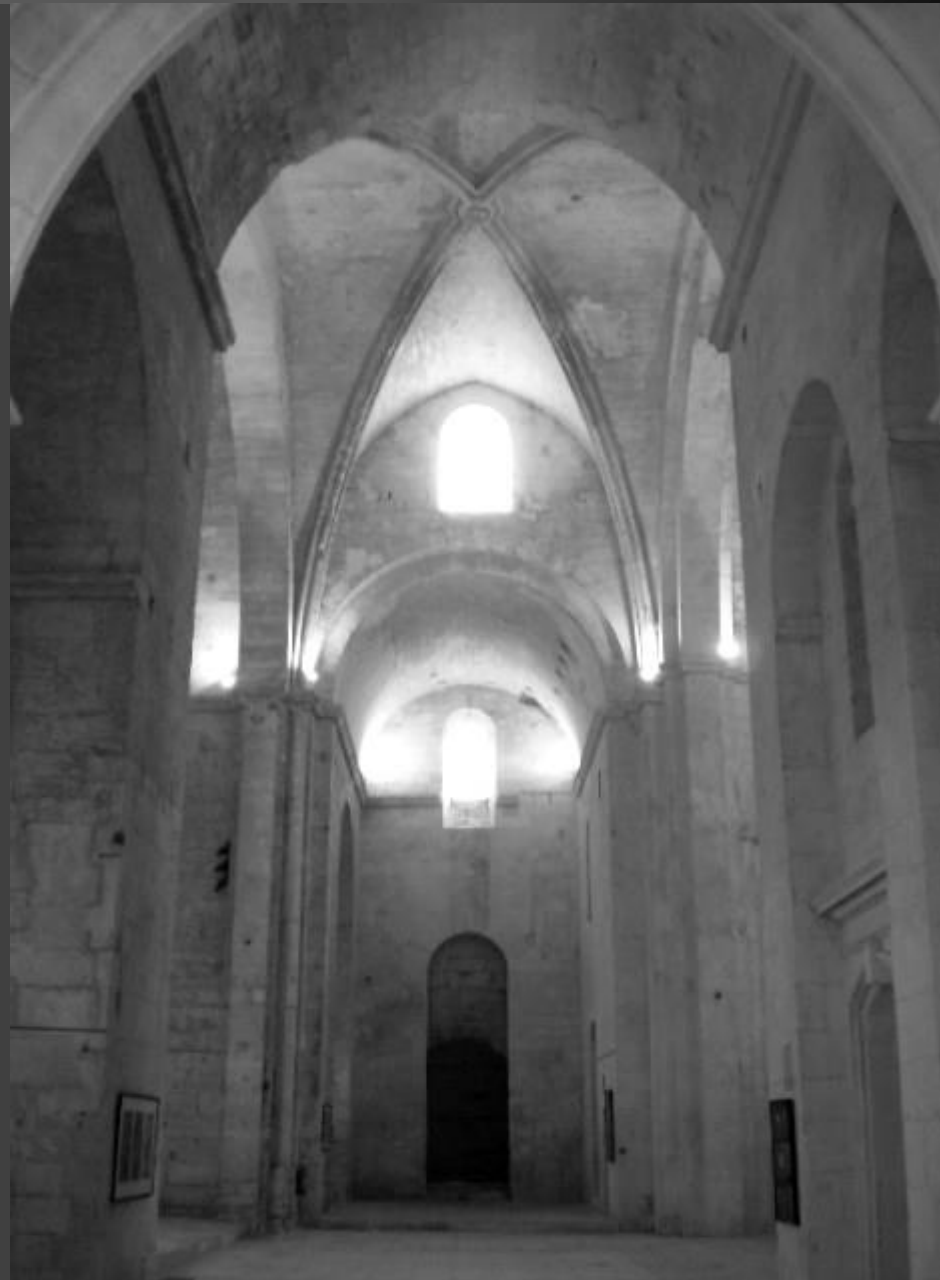
LE TRANSEPT_ Voûte de la croisée et Croisillon Sud.
