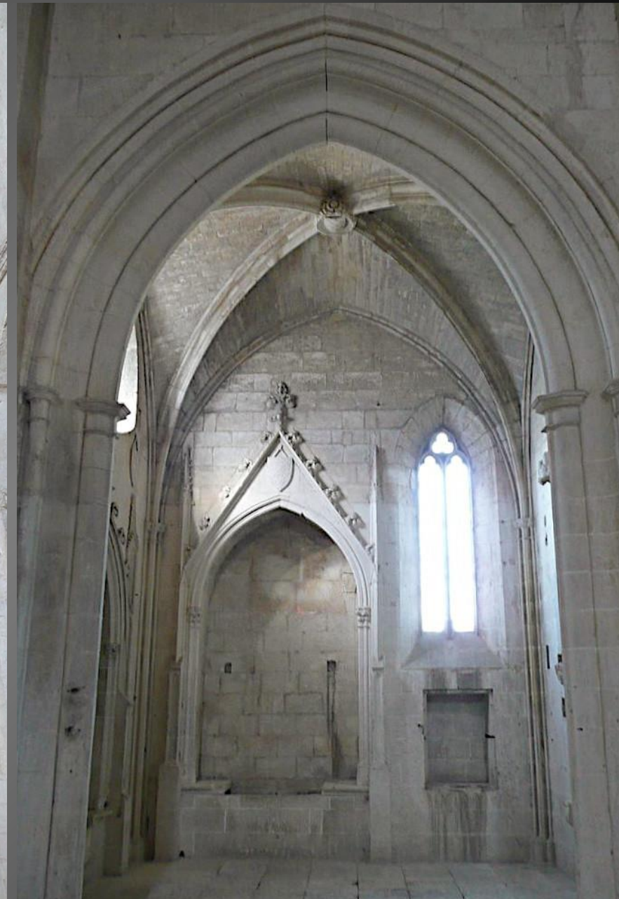
LE TRANSEPT _ Le croisillon nord s'ouvre sur une chapelle gothique, édifée en hors-œuvre au début du XIVe siècle, sous le vocable de Notre-Dame-la-Blanche du nom d'un groupe en marbre représentant entre autres la Vierge dont on peut encore voir quelques vestiges.
