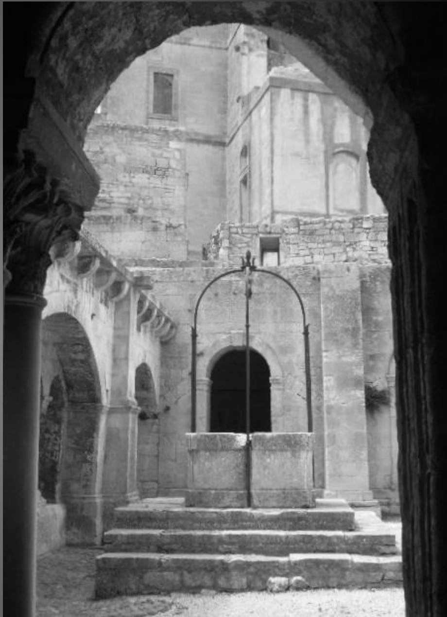
La galerie ouest, remaniée au XVIII e siècle afin de pouvoir supporter les deux étages prévus par la reconstruction mauriste, a cependant conservé son ordonnancement intérieur.
