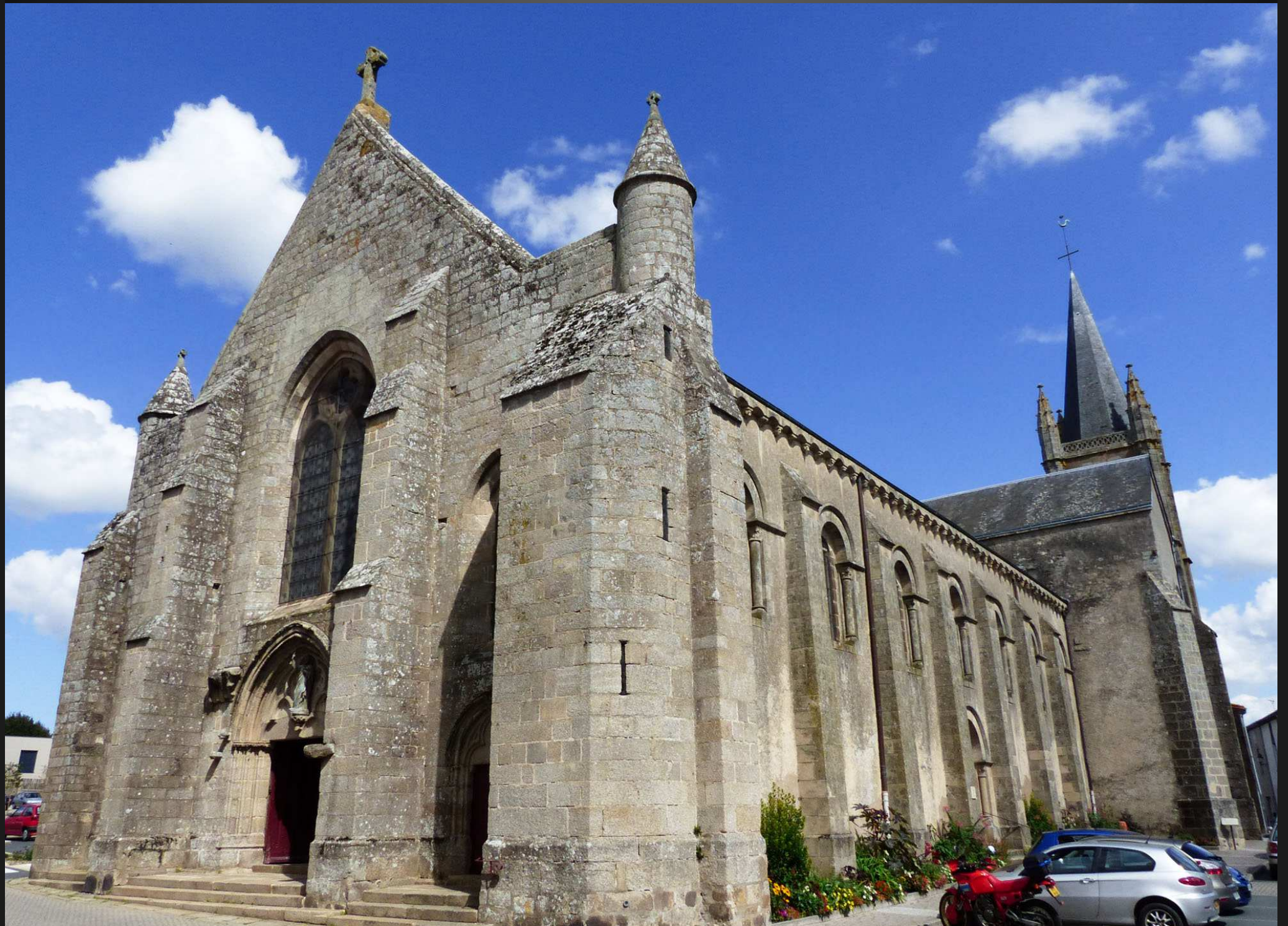
EGLISE SAINT-PIERRE DE MORTAGNE _ Vue générale de l'édifice à partir de la façade Nord.
