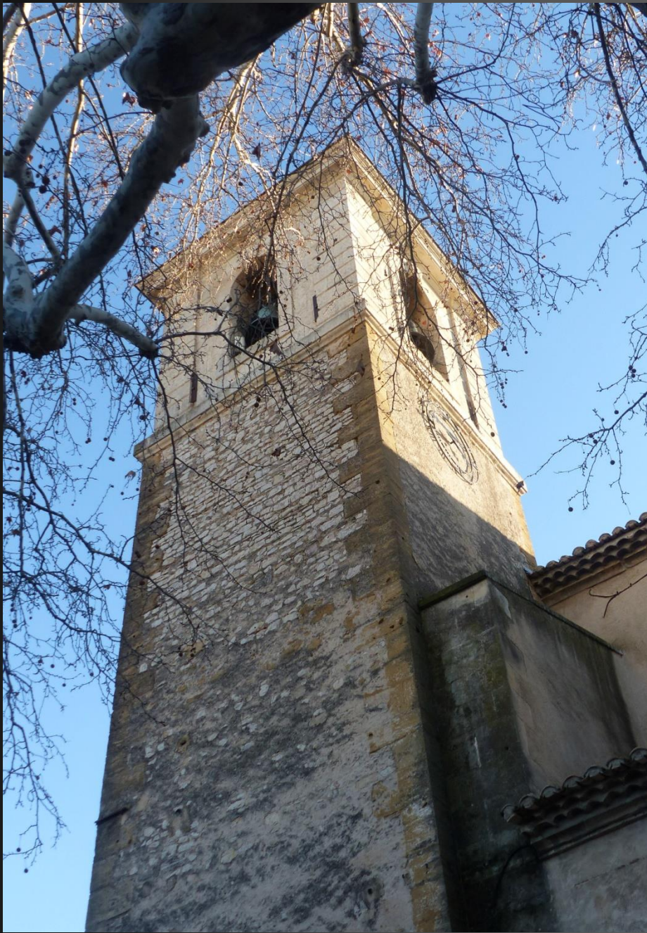
MOURIES _ Le haut clocher de l'église Saint-Jacques-le-Majeur, coiffé à l'origine d'une sorte de bulbe, fut détruit par un tremblement de terre en 1909 et rebâti ensuite sous sa forme actuelle.
