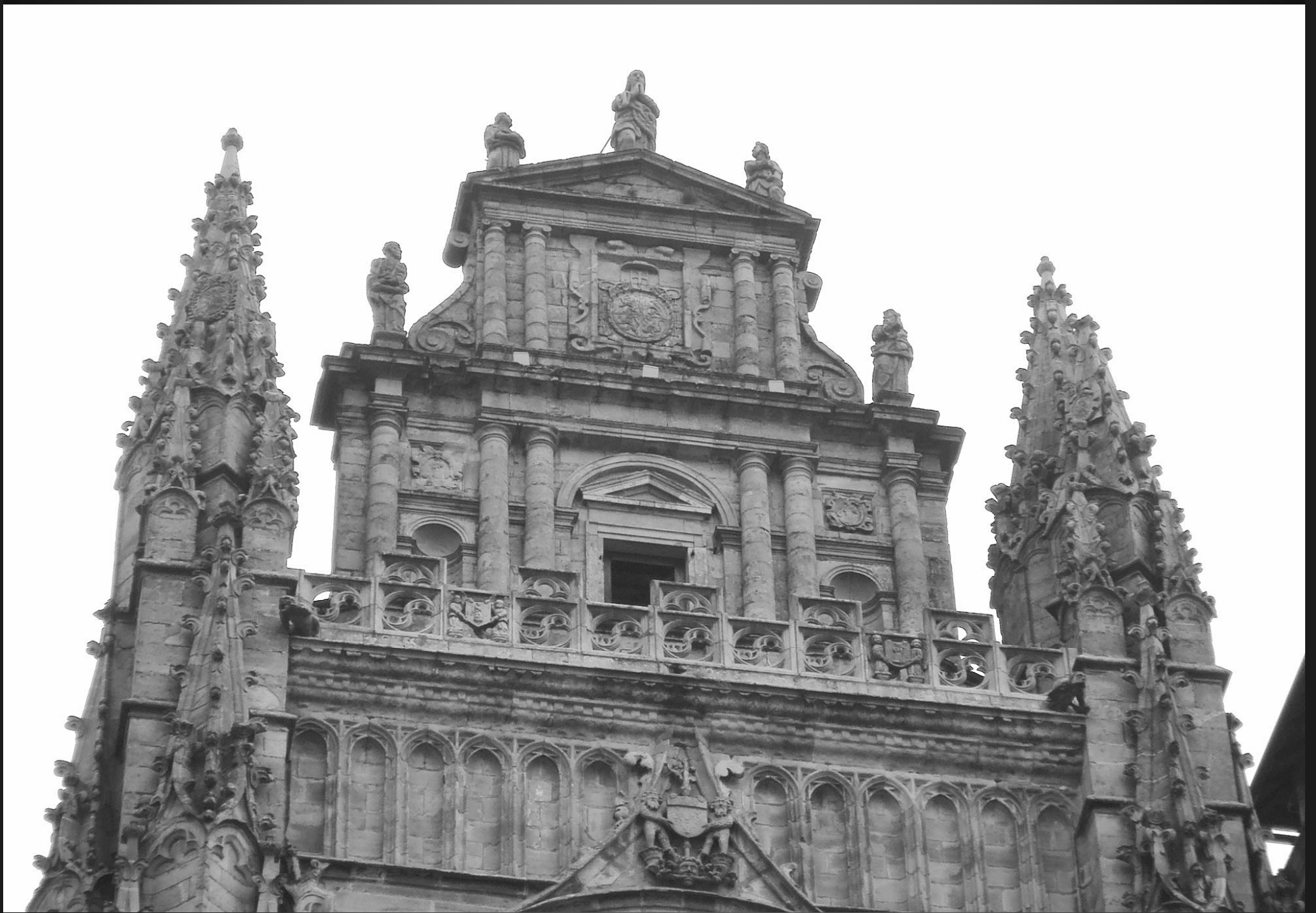
CATHEDRALE NOTRE-DAME DE RODEZ _ Sans souci d'unité architecturale, Georges d'Armagnac (1501-1585, évêque de Rodez) a fait couronner le sommet de la façade fortifiée de la cathédrale gothique par le modèle réduit d'une façade d'église italienne avec porte, colonnade et un frontispice classique (fronton et consoles à spirale) dessiné en 1562 par Guillaume Philandrier (1505-1563, humaniste et ami de François Rabelais, qui fut chanoine de Rodez.
