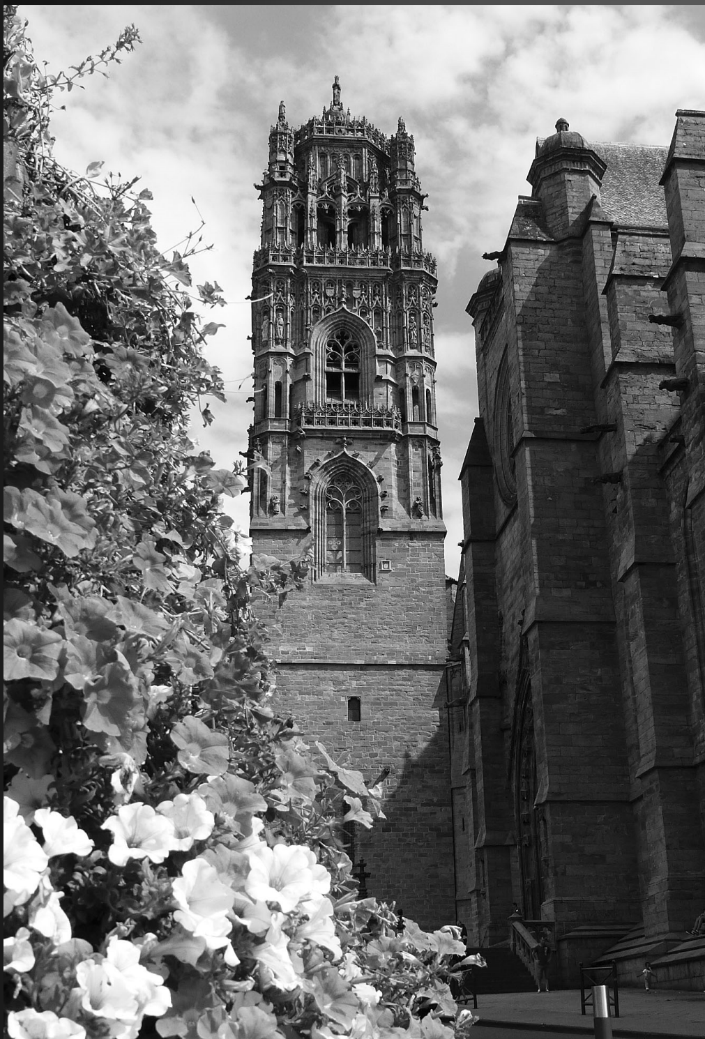
LE CLOCHER _ Les travaux du clocher haut de 87 mètres sont achevés en 1526.
