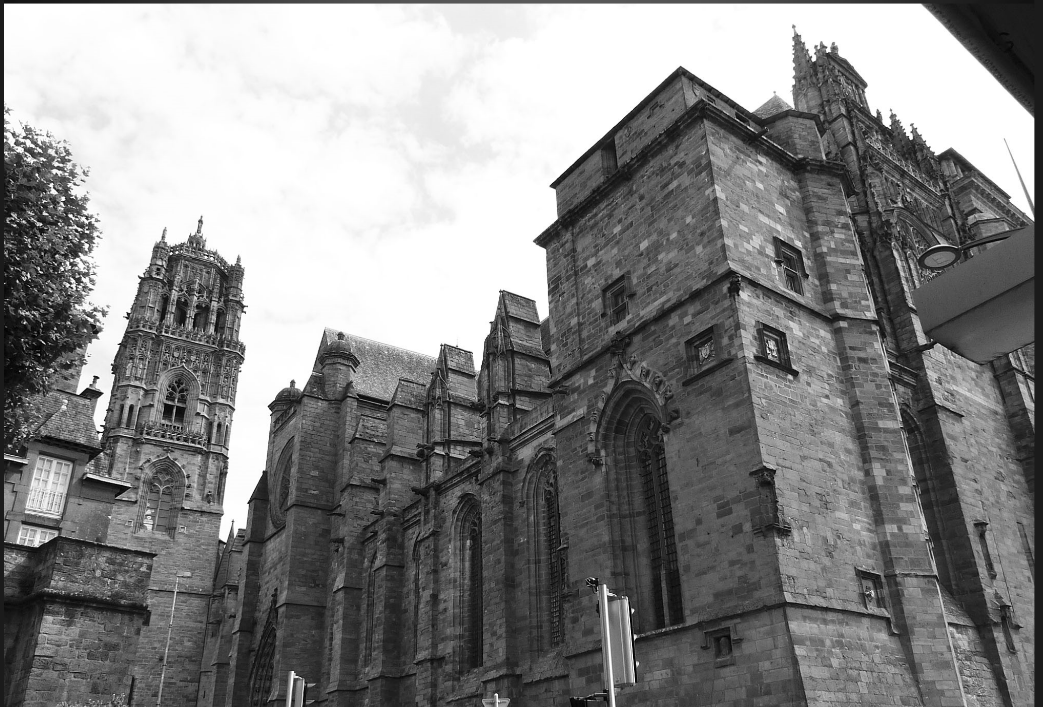
CATHEDRALE NOTRE-DAME DE RODEZ _ Bien que les travaux de construction aient duré de 1277 jusqu'à la fin du XVIe siècle, la cathédrale bénéficie d'une remarquable unité tant à l'intérieur qu'à l'extérieur. En effet, le plan général de l'édifice est attribué à l'architecte Jean Deschamps, qui a mis en pratique dans le Midi les principes de l'architecture gothique définis dans la France du Nord: on peut établir des similitudes entre la cathédrale de Rodez et celles de Clermont-Ferrand dont Jean Deschamps a dirigé la construction entre 1248 et 1265, Narbonne où Jean Deschamps est nommé « magister principalis operis ecclesiae » en 1286, Limoges... (Source : https://fr.wikipedia.org/wiki/Cathédrale_Notre-Dame_de_Rodez )
