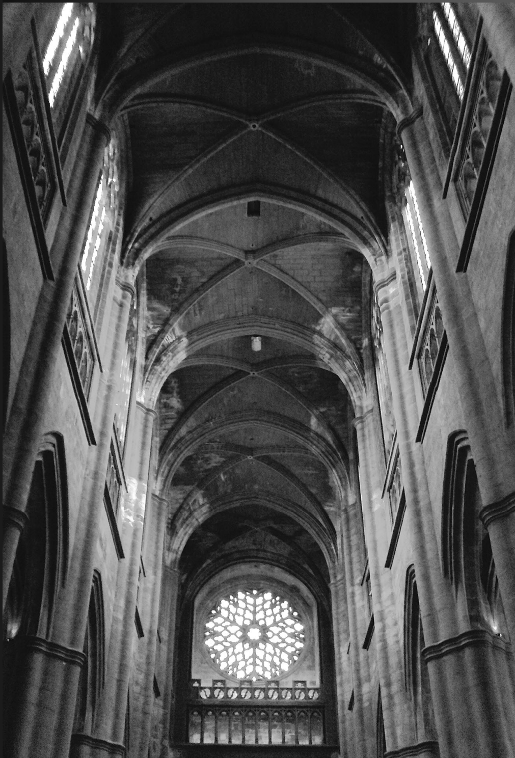
LA NEF _ Les six travées sont éclairées par la grande rosace de la façade et les hauts vitraux latéraux.
