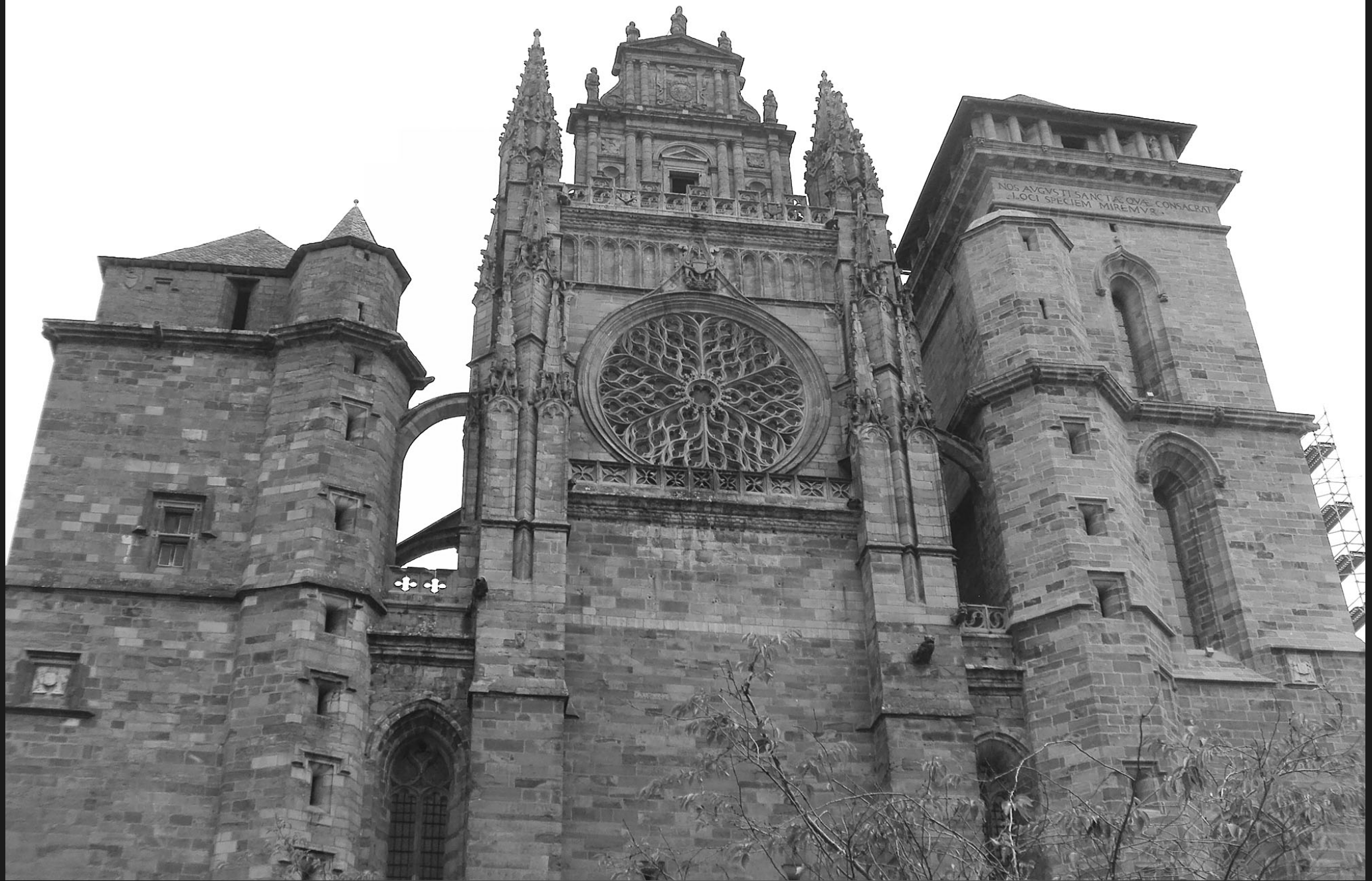
CATHEDRALE NOTRE-DAME DE RODEZ _ L'aspect sévère de la façade occidentale (en grès permien rose à tonalité rougeâtre), témoigne de sa vocation défensive : elle est flanquée de deux tours massives qui étaient incorporées aux remparts. La rigueur de l'ensemble est rompue par un frontispice flamboyant placé au faite de la façade au milieu du XVIe siècle.
