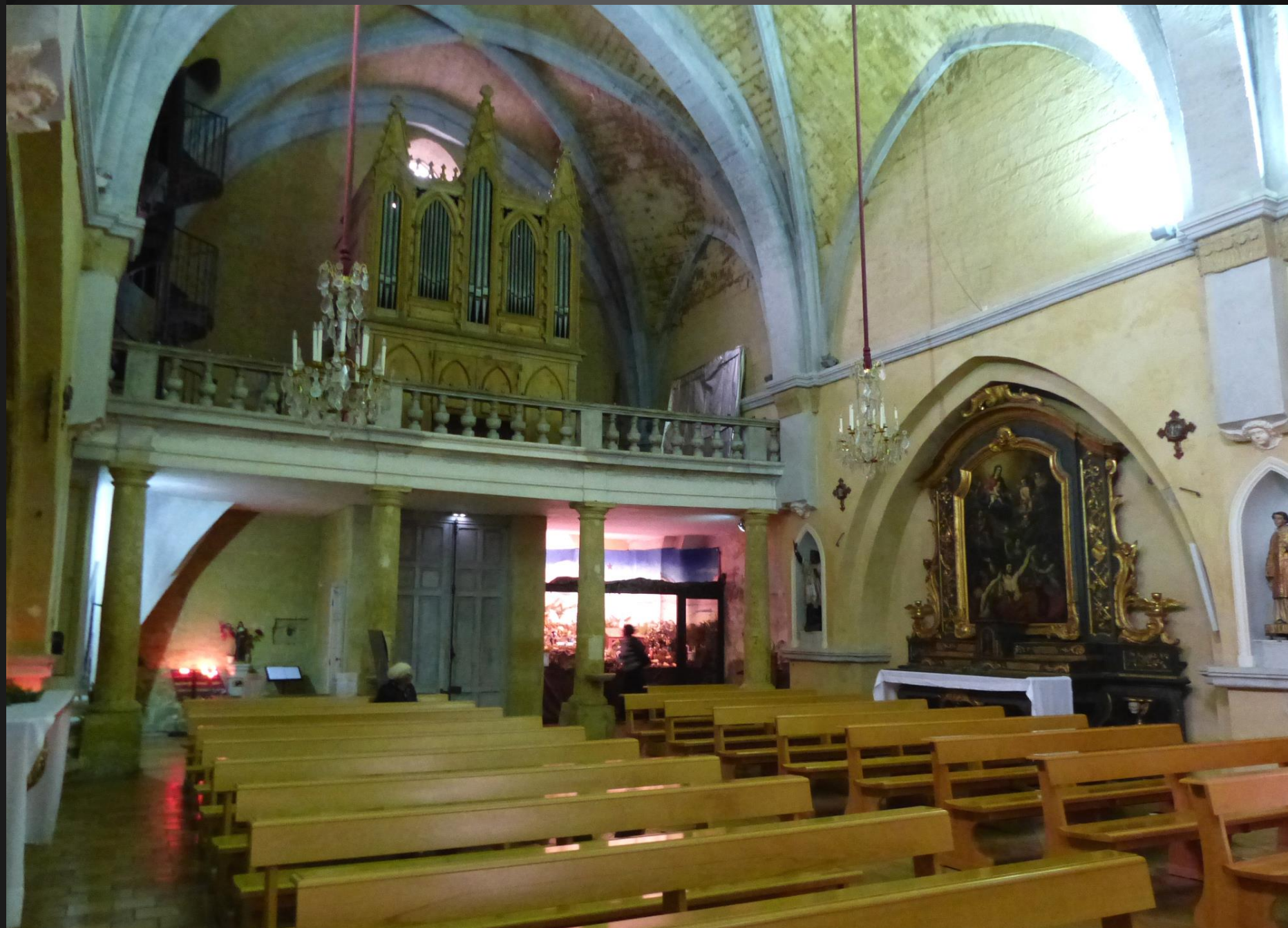
Eglise Saint-Michel _ La tribune, située à 3.2 m du sol (hauteur de la nef 10.03m) et supportée par quatre piliers de pierre, fut construite vers 1810, remplaçant un autel dédié à St Jean.
