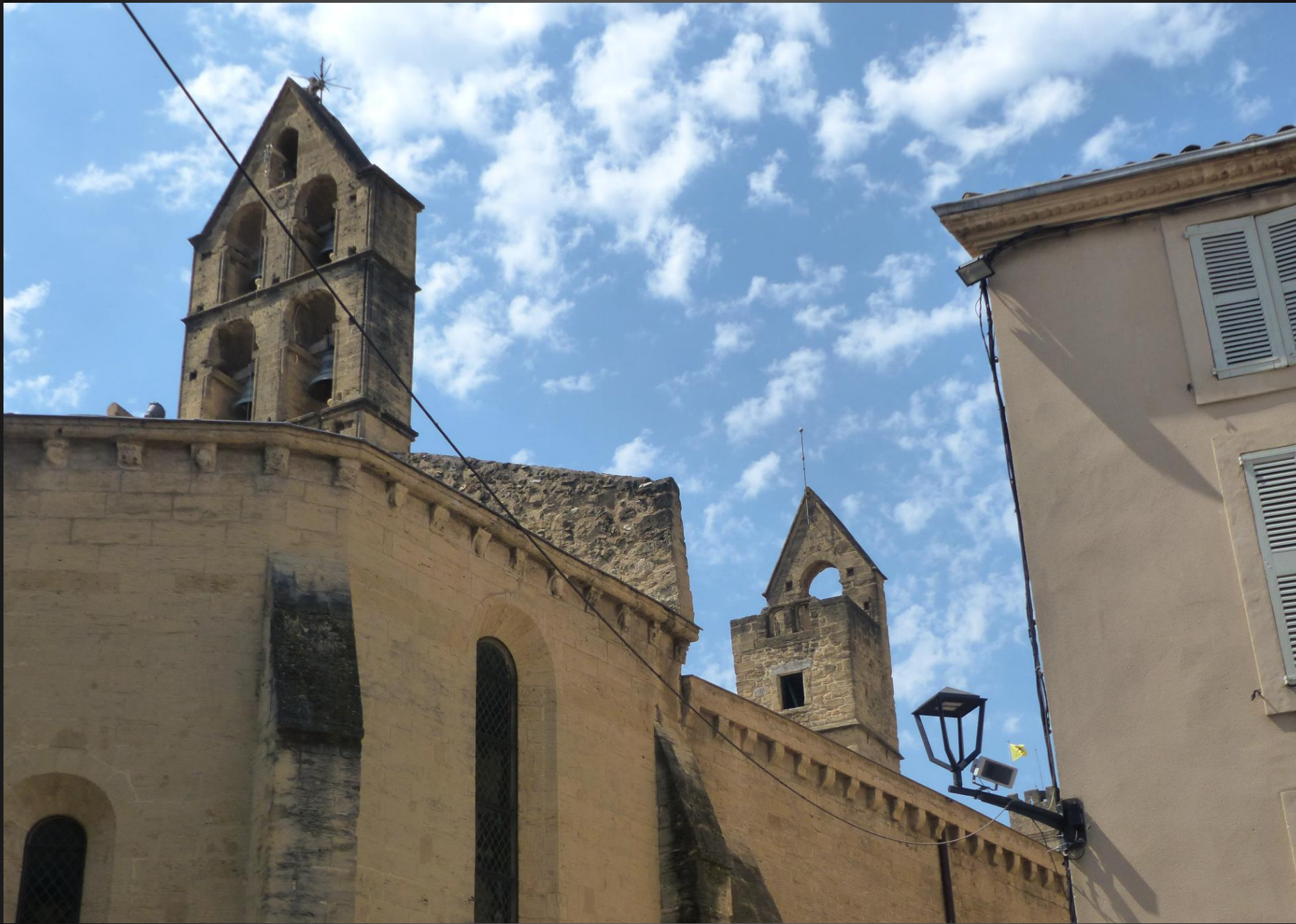
Eglise Saint-Michel _ Ce monument, dit de style « transitoire » entre l'art roman et le gothique provençal, apparaît dès le début du XIIIe siècle aux côtés des églises Saint-Laurent et Sainte-Marie. La tour et le clocher à arcades semblent appartenir à la même campagne de travaux que l'abside, cependant, le second fut ajouté au XVe siècle pour recevoir l'horloge de la ville, qu'il gardera jusqu'au XVIIe siècle.
