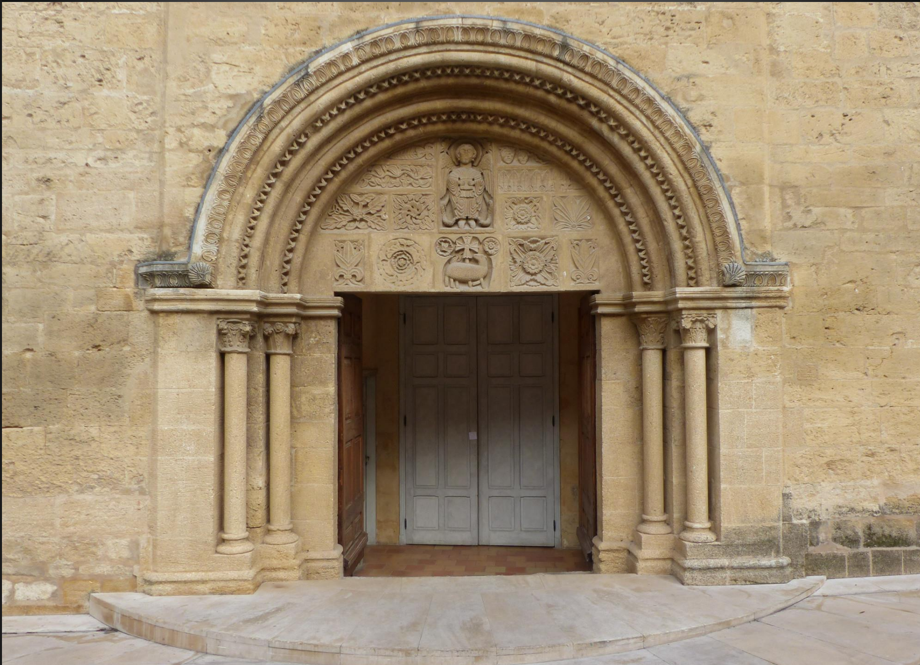
Eglise Saint-Michel _ Le portail de style roman, avec ses quatre colonnettes et une triple archivolte, est remarquable par la qualité des sculptures de son tympan.
