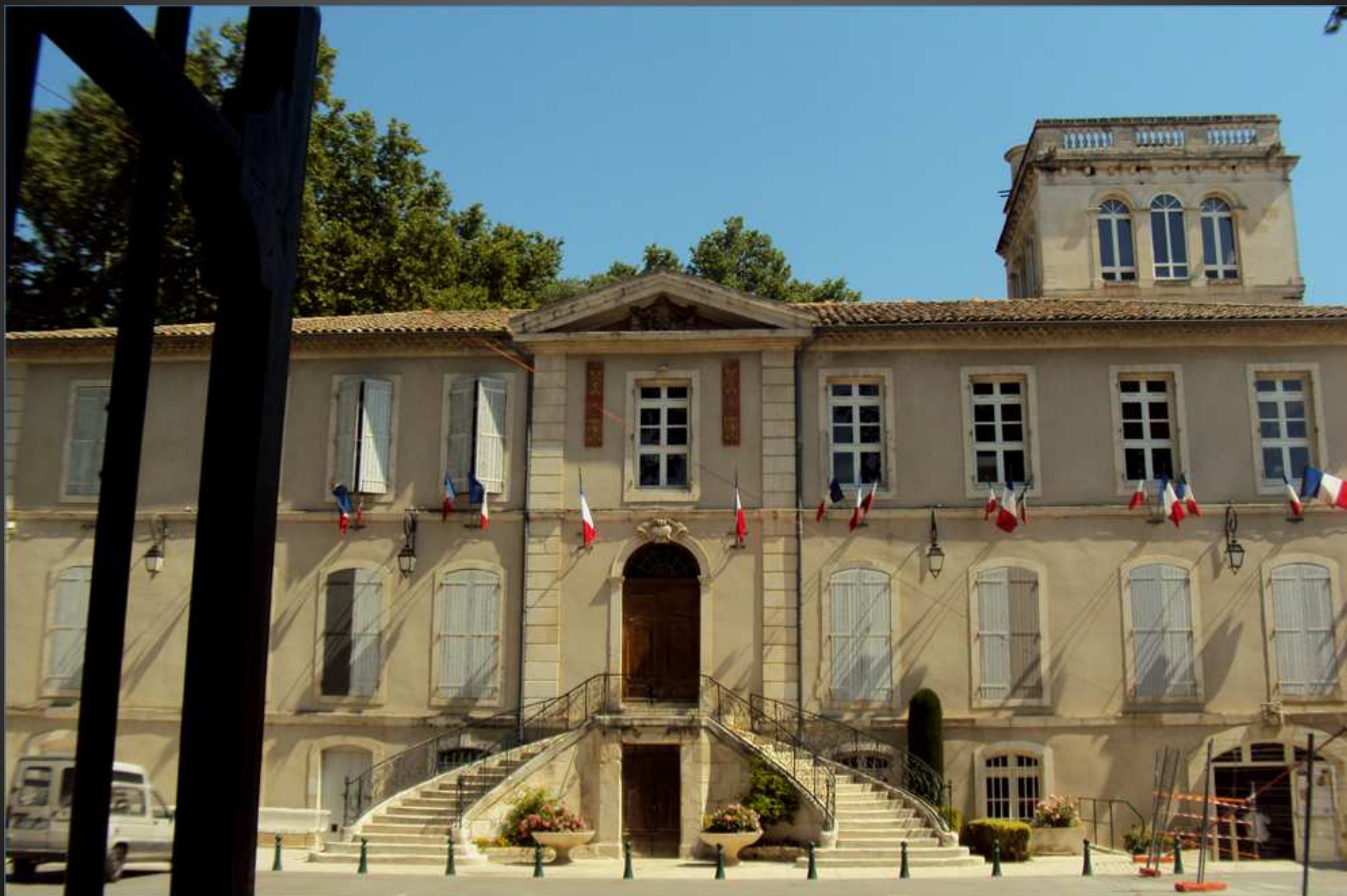
Le Château de ST ANDIOL, où était tenue toute la journée une expositions de postes de radio des années 1940-1945, avec démonstrations de liaisons.
