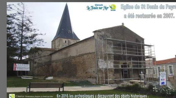
Restauration de l'église Saint-Denis (photo du web)
