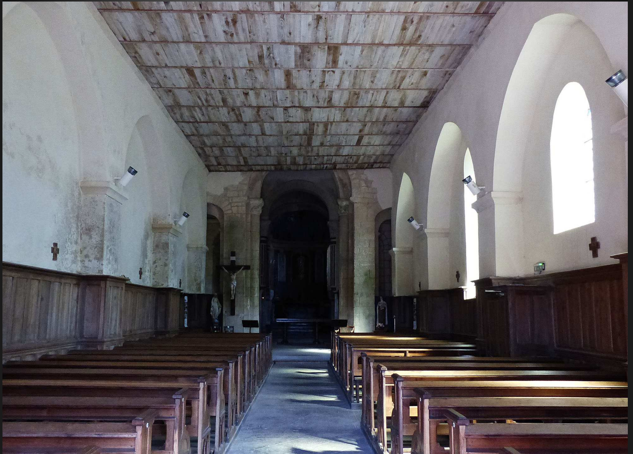
EGLISE SAINT-DENIS-DU-PAYRÉ _ La nef du XVIIIe siècle comporte quatre travées restaurées en 1893 ; elle est éclairée côté sud de quatre fenêtres dont les plus grandes datent du XIXe siècle.
