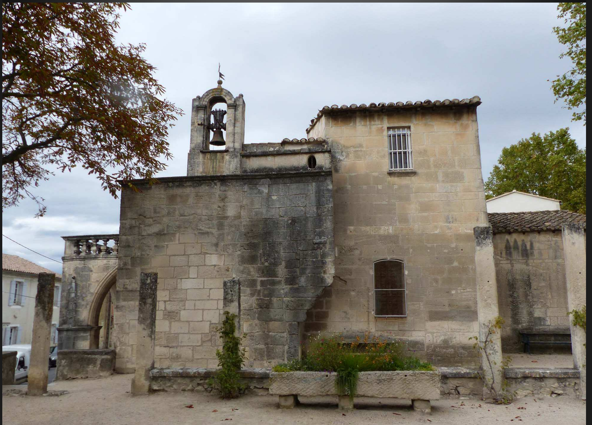
Les différentes phases de la construction sont apparentes.
