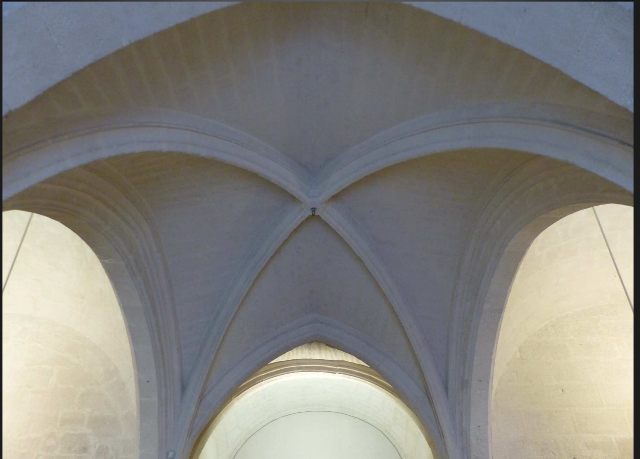
Architecture gothique, élégante voûte en croisée d'ogives.
