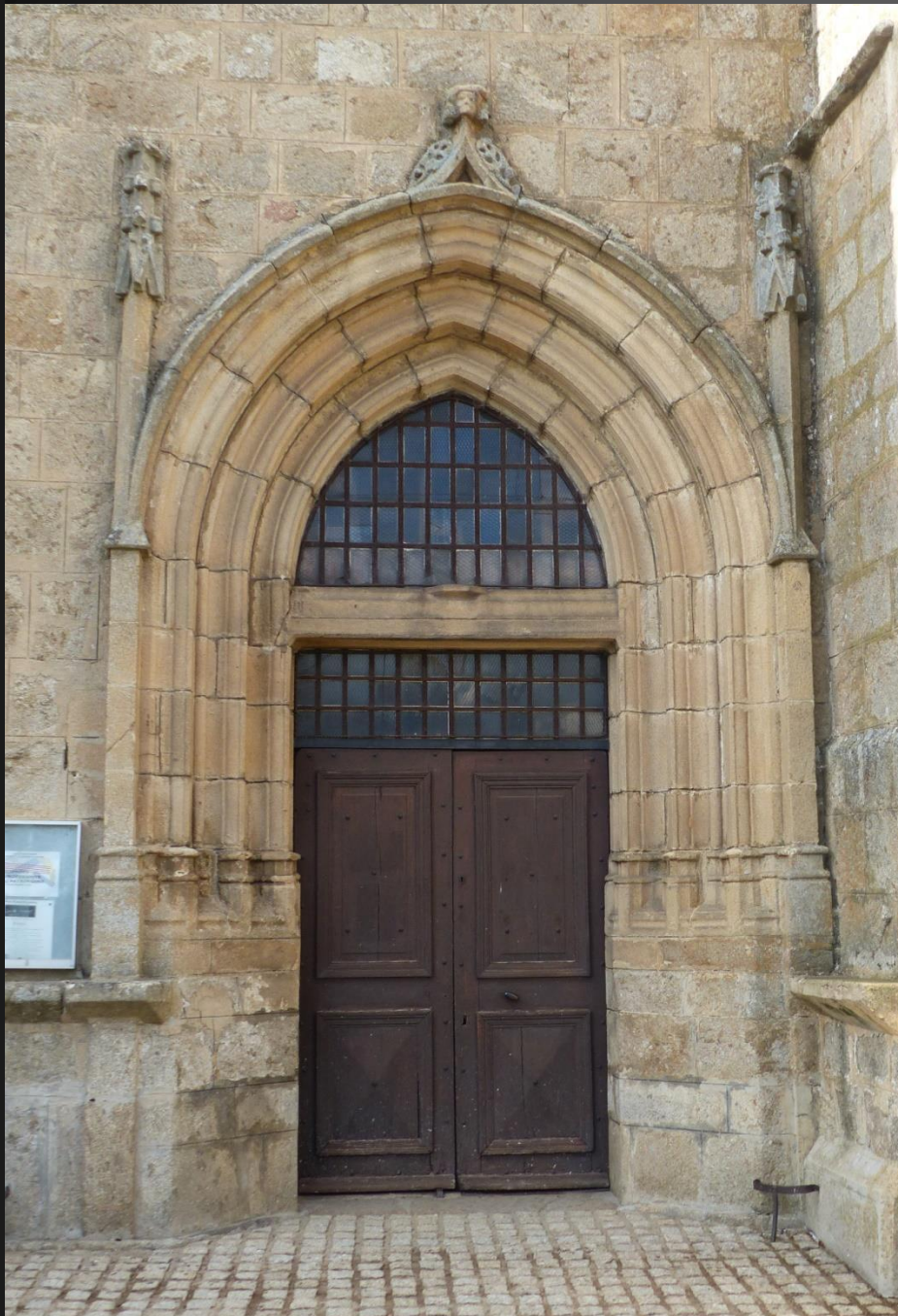
ST ROMAIN _ Le portail d'entrée date du XVIe siècle.
