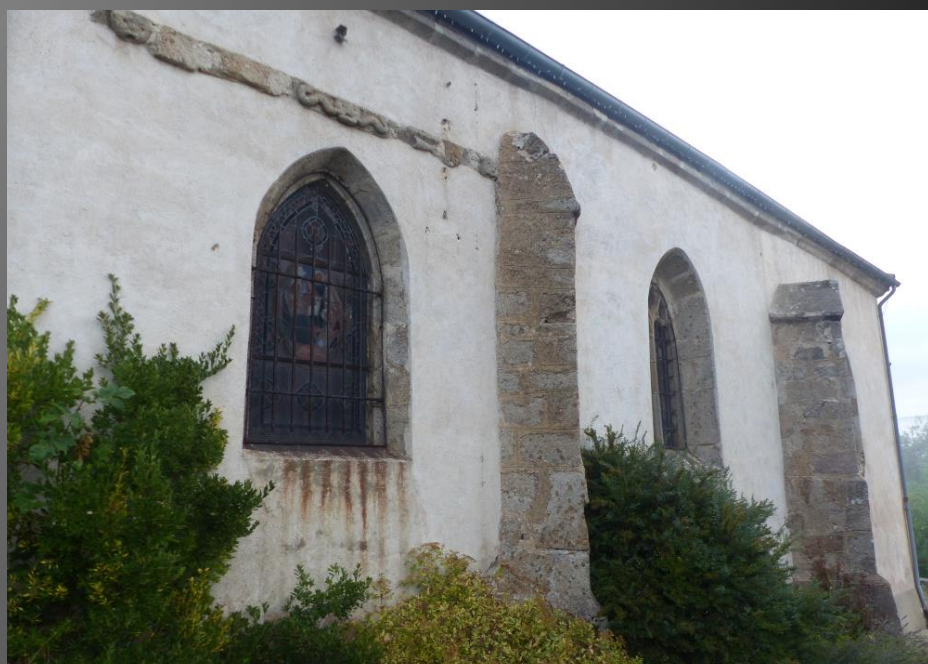
ST ROMAIN _ 1811 : réfection du clocher. 1894 : côté sud, doublement des fondations et réfection des contreforts suite au déblaiement de l'ancien cimetière.
