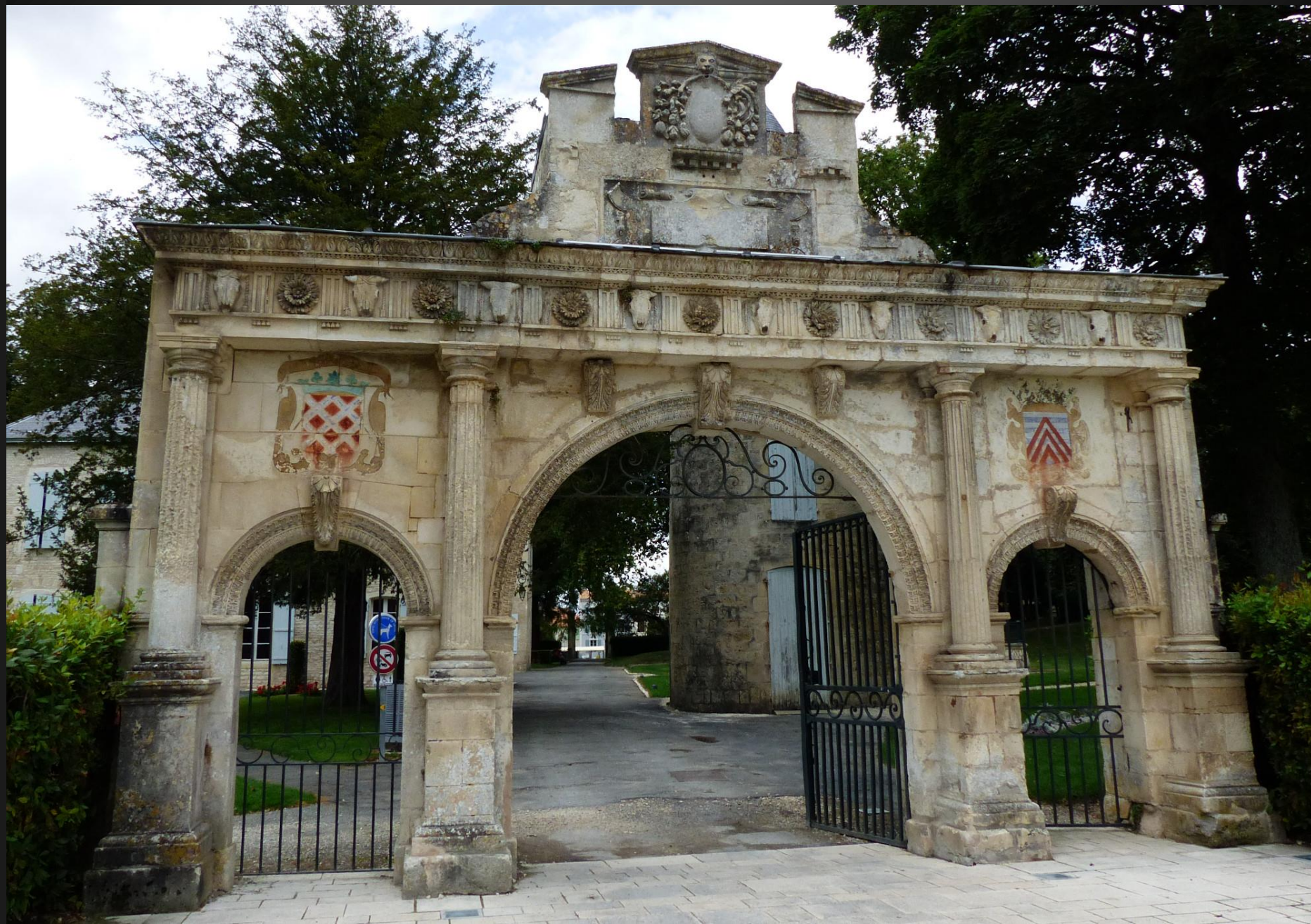
SURGERES_ La Porte de style Renaissance aux colonnes toscanes, édifée en 1471 par le frère d'Hélène de Surgères, Charles de Fonsèque : Blason de la ville, Armoiries de la maison de La Rochefoucauld - Devise de la ville « Post tenebras spero lucem », ce qui signifierait « Après les ténèbres, l'espoir de la lumière », dont l'auteur, Henri de Fonsèque, était le seigneur de la cité.
