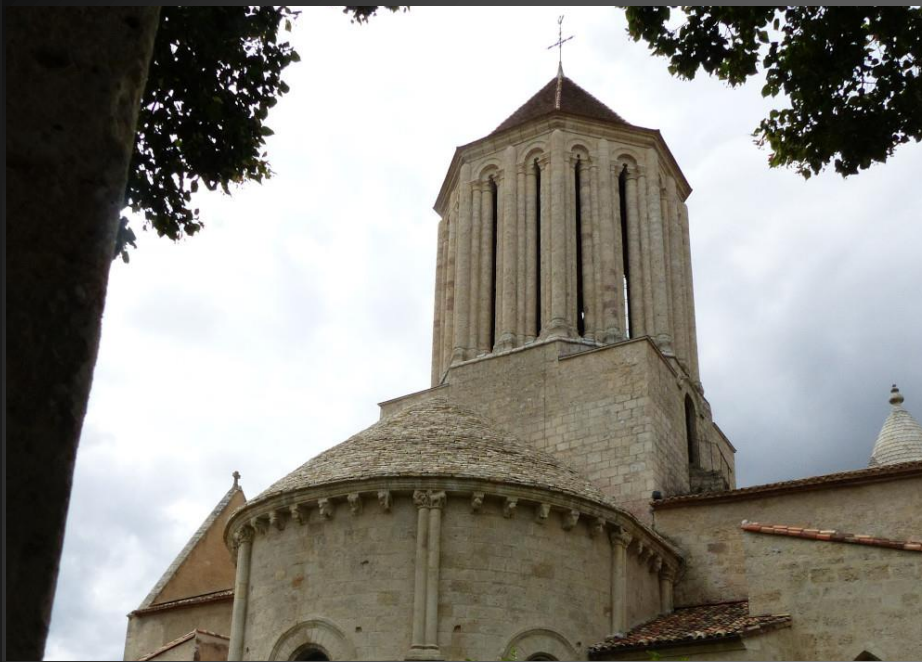
Le clocher et la façade avant restauration
