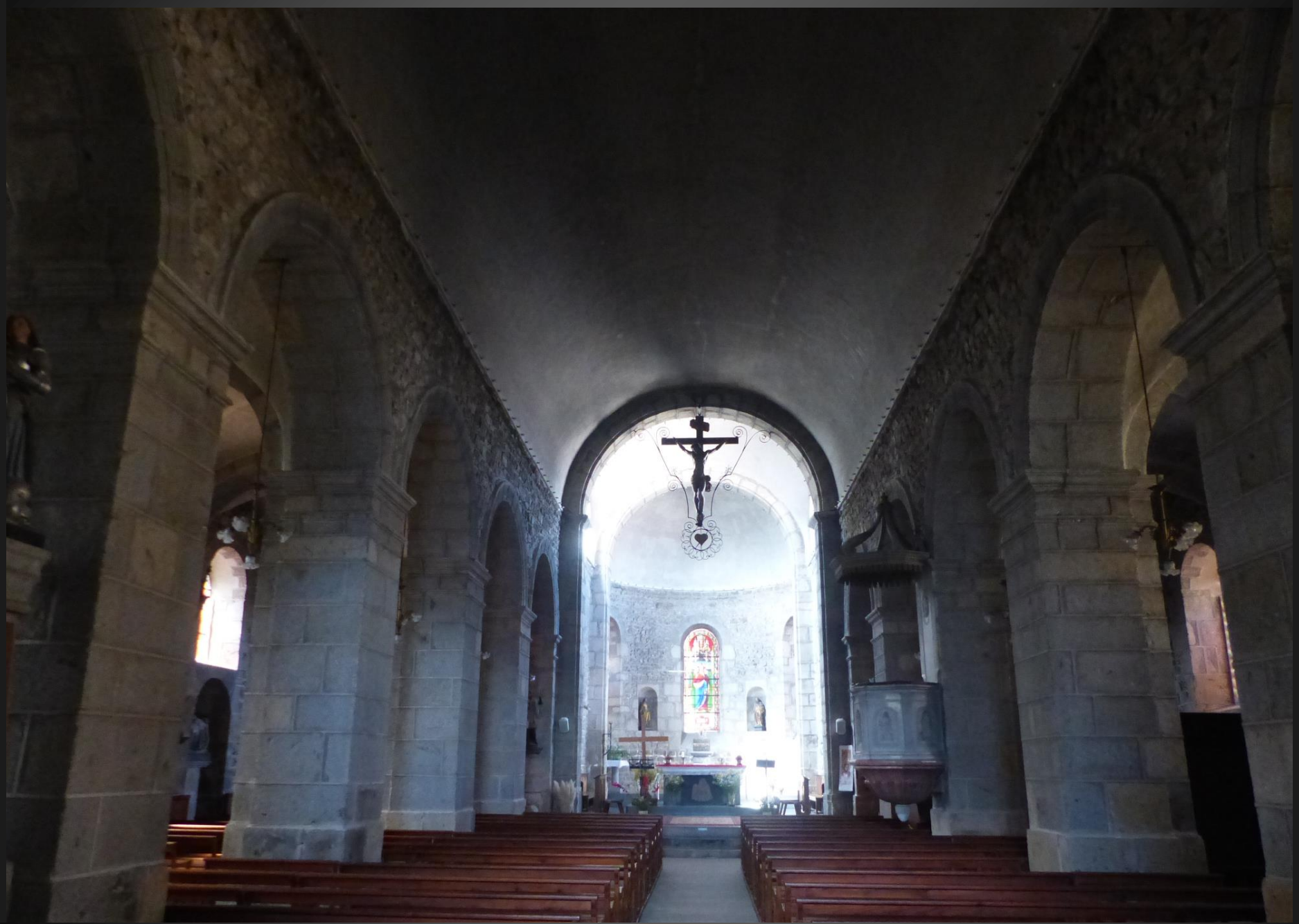
VIVEROLS _ Le vaisseau principal est épaulé par deux bas-côtés ouverts par cinq baies en plein cintre, dont une surmontant une porte ; on trouve également une niche en plein cintre. Des corniches courent le long de la nef et des bas-côtés.
