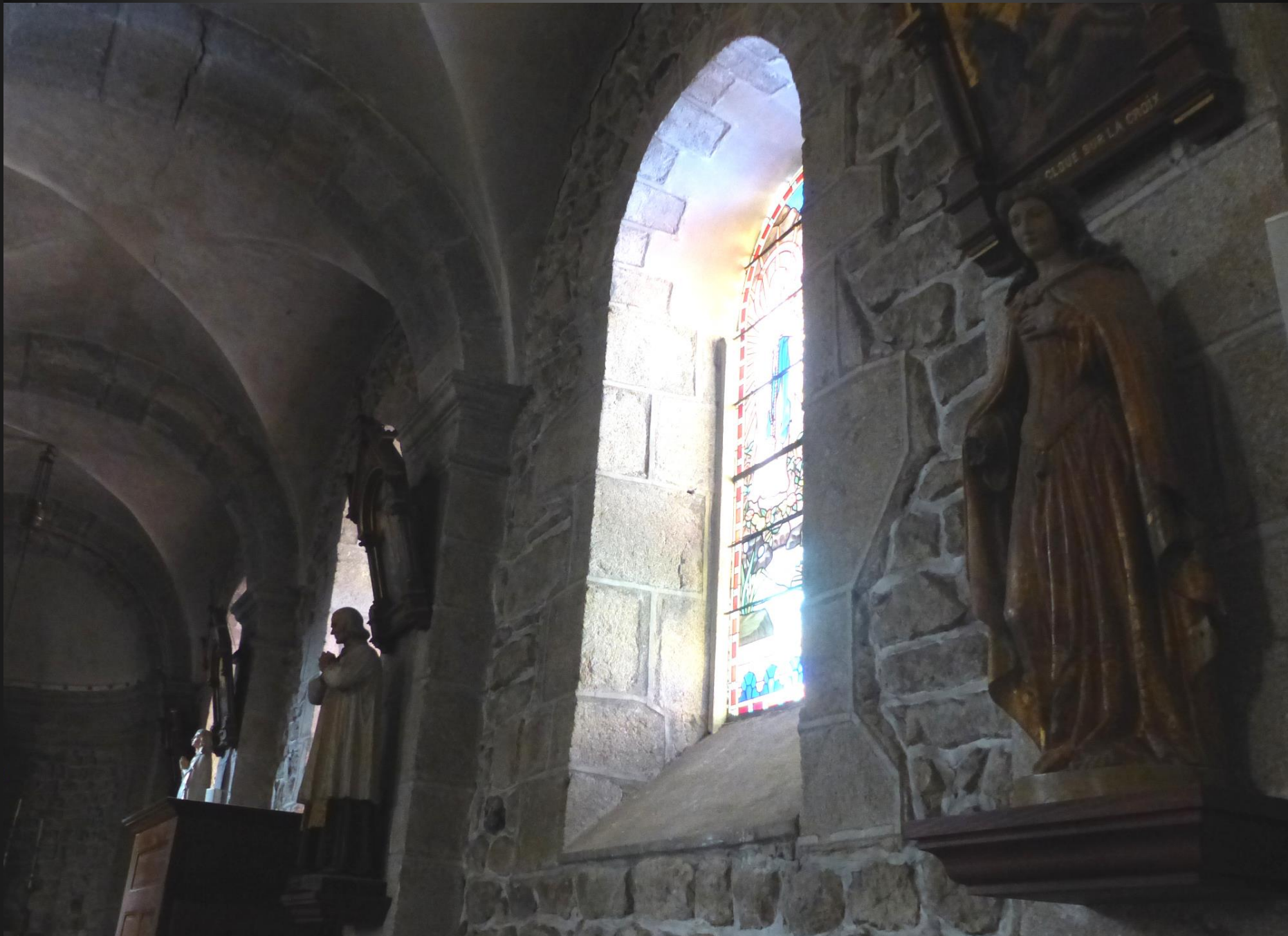
VIVEROLS _ Les murs pignons des bas-côtés sont scandés par des niches en plein cintre.
